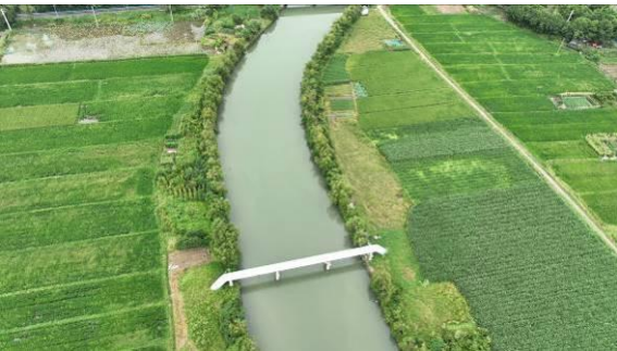
隧洞后段管线
