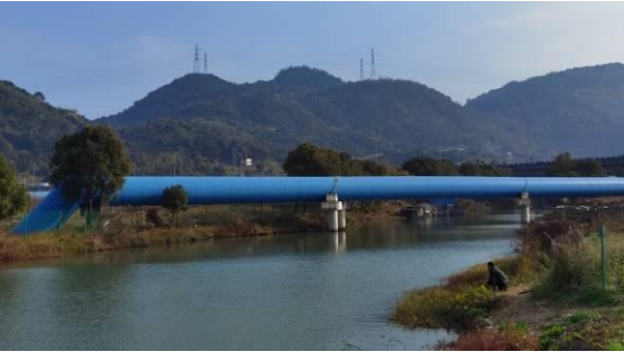
隧洞前段管线
