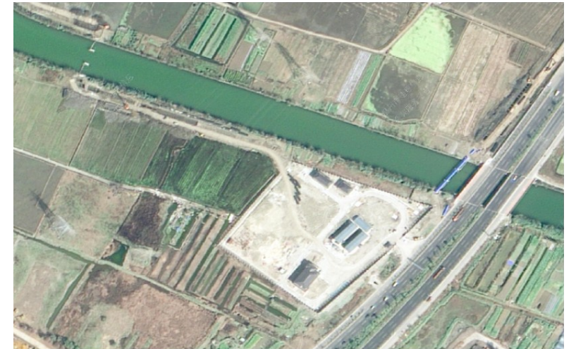
天河泵站及隧洞后段管线（建设中）
