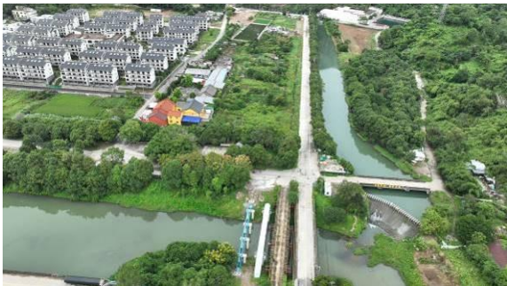
隧洞后段管线
