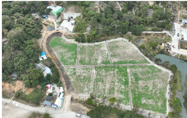
隧洞段出口（建设后）
