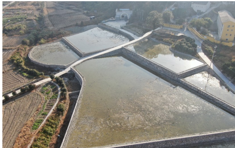
隧洞段入口（建设后）
