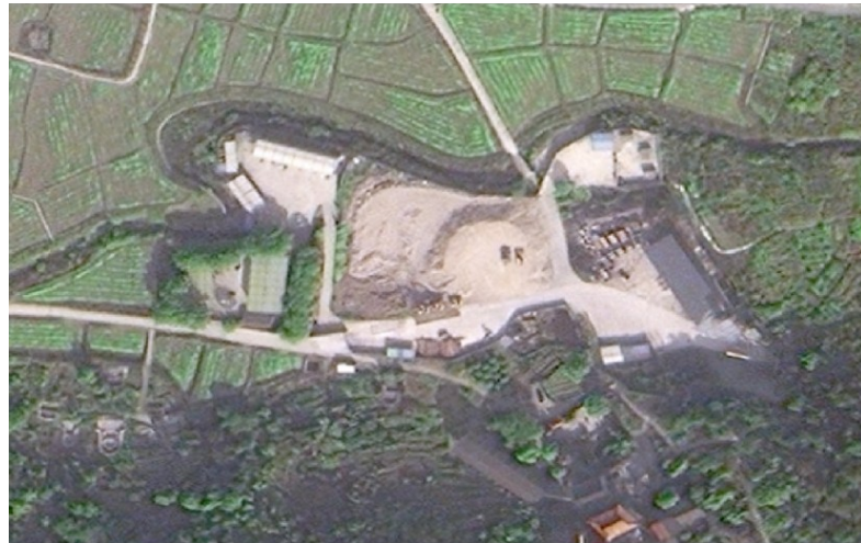
隧洞段入口（建设中）
