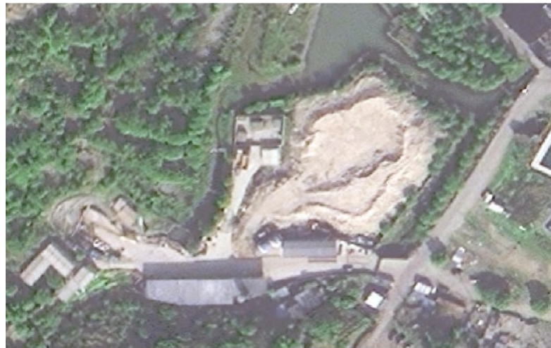
隧洞段出口（建设中）
