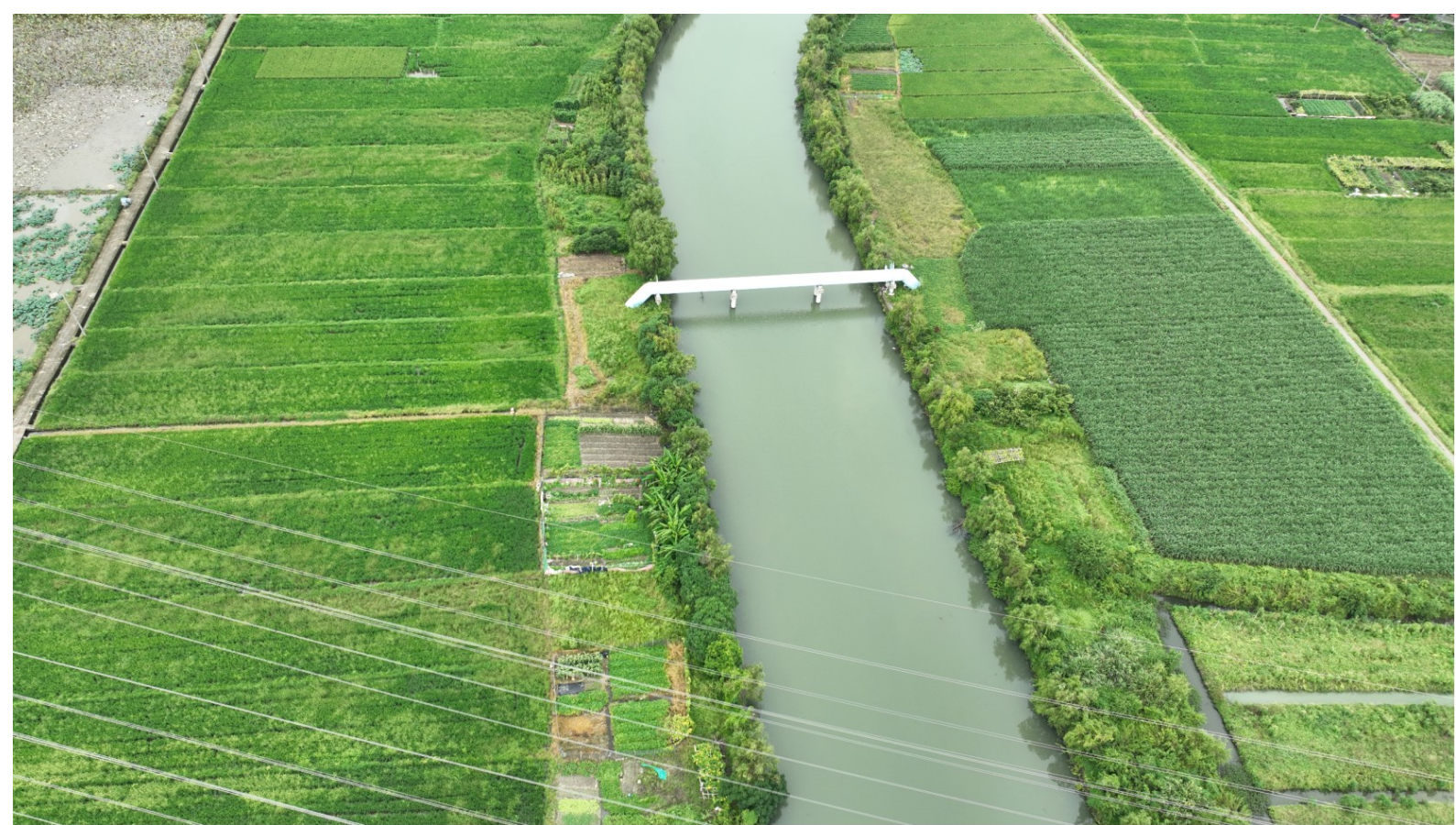
管线工程土地复垦
