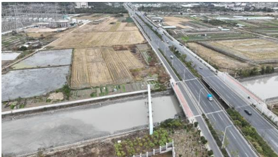
隧洞后段管线
