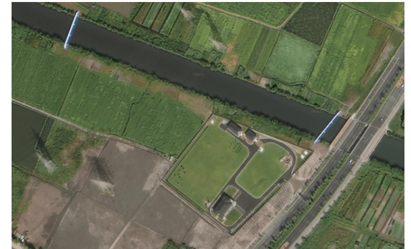
天河泵站及隧洞后段管线（建设后）
