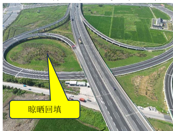
图 3-4 淤泥、钻渣互通区晾晒回填区（完工后）
