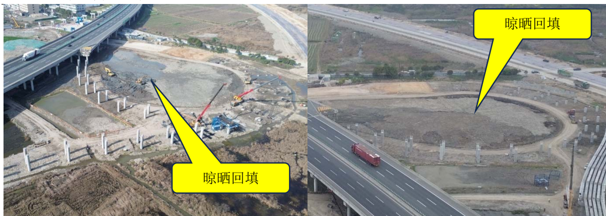
图 3-1 淤泥、钻渣互通区晾晒回填
