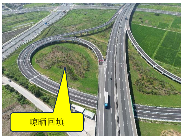
图 3-3 淤泥、钻渣互通区晾晒回填区（完工后）
