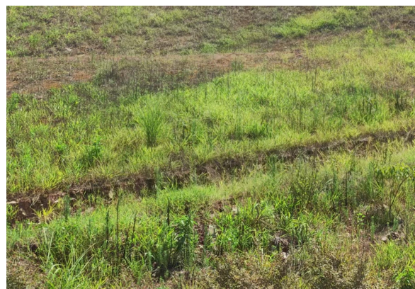
图 3.1-1 开挖边坡现状图（2024.10）
