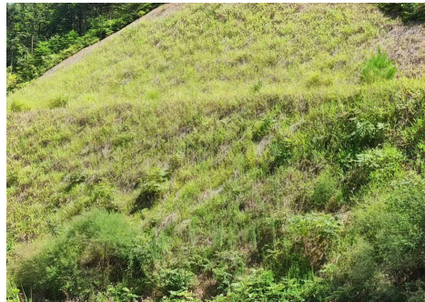
图 1.1-3 边坡现状照片
