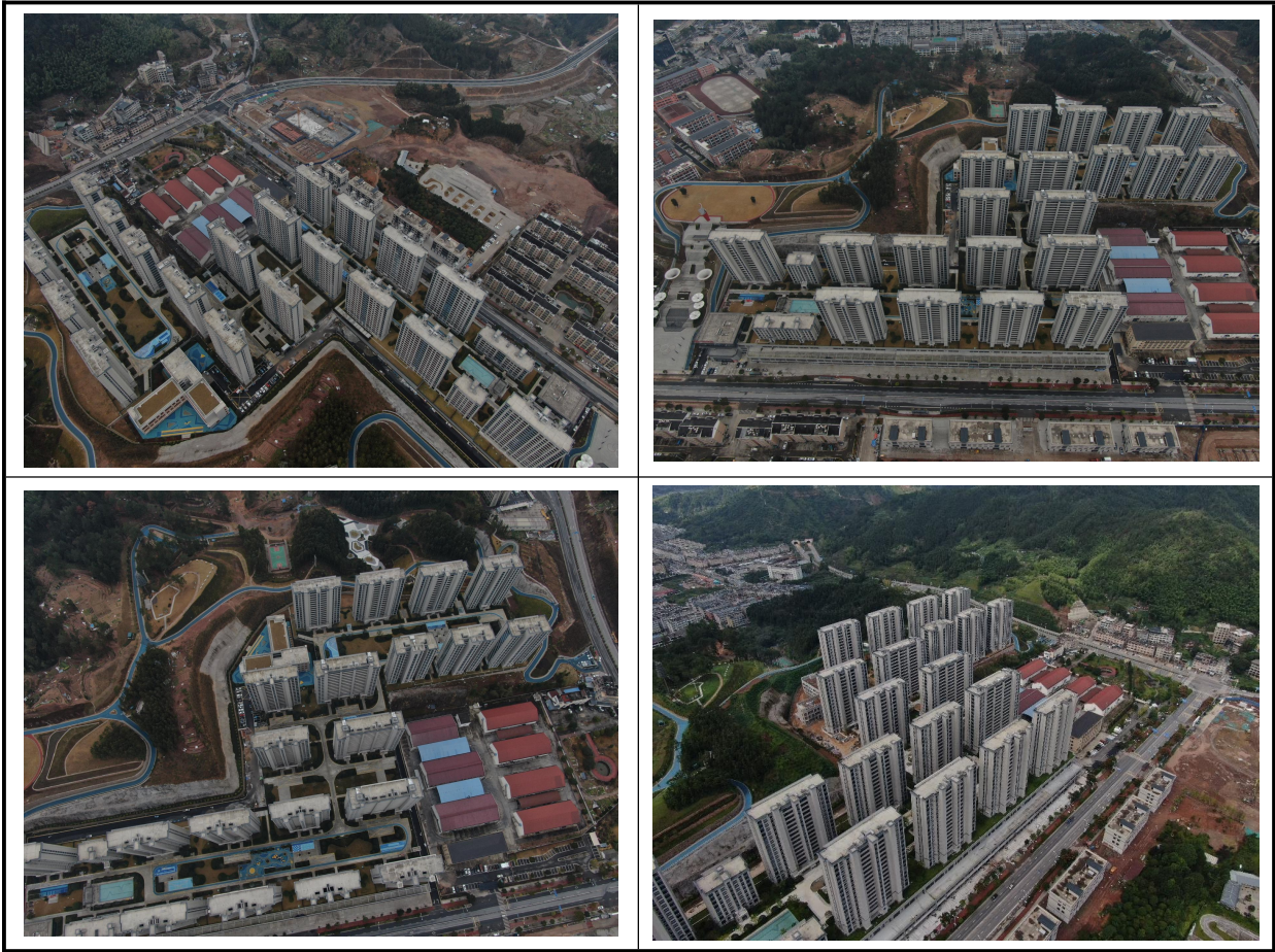
项目区竣工验收照片（2023.10）
