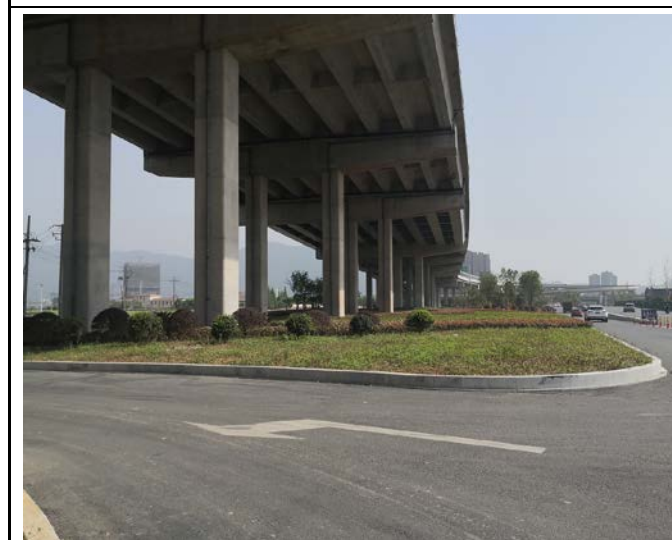
地面道路及绿化现状 (2023.06)
