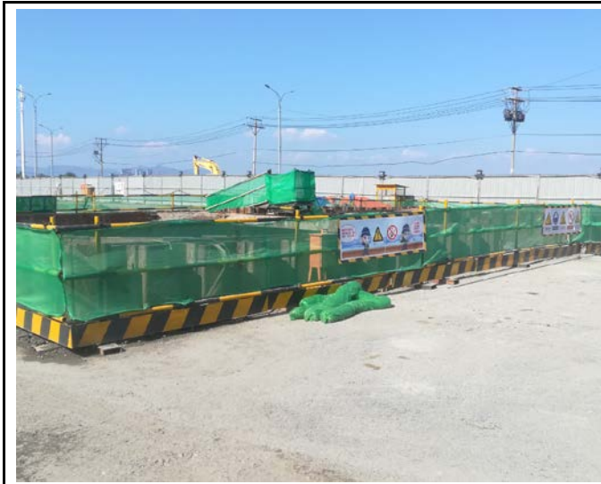
S3 线基坑开挖区（2020. 09）
