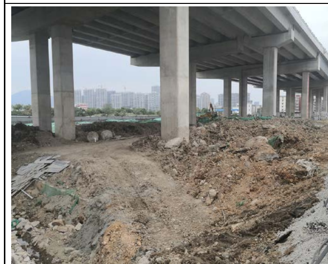
主线高架桥桥下裸露区域（2022. 12）
