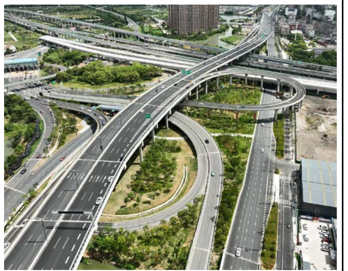
温州南互通景观绿化施工（3标）（2023.12）
