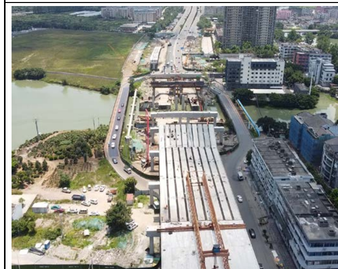
终点处高架桥、地面桥（3标）（2022.06）
