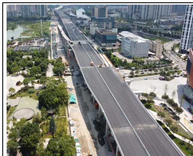
主线高架路面及地面道路（2标）（2022.06）
