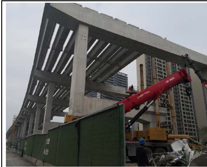
主线桥施工现状（2021.12）
