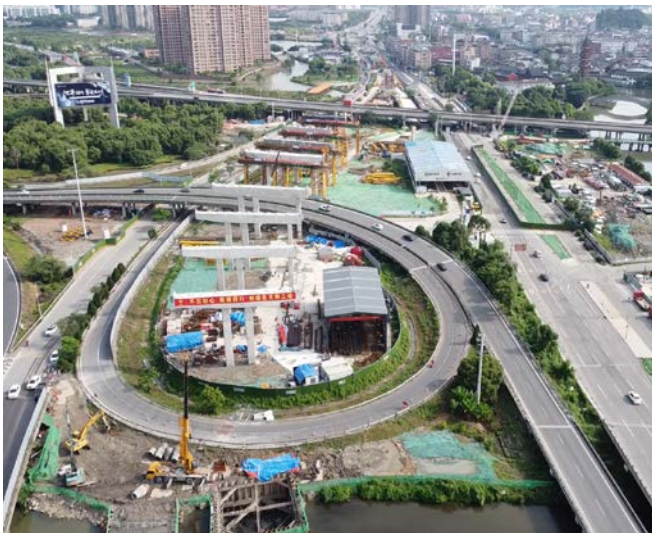
立柱、盖梁施工现状（3 标）（2021.06）
