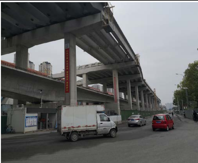
主线桥施工现状（2021.12）
