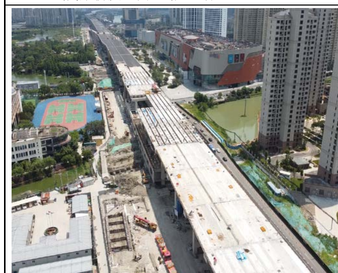
主线高架桥、地面桥施工（2标）（2022.06）
