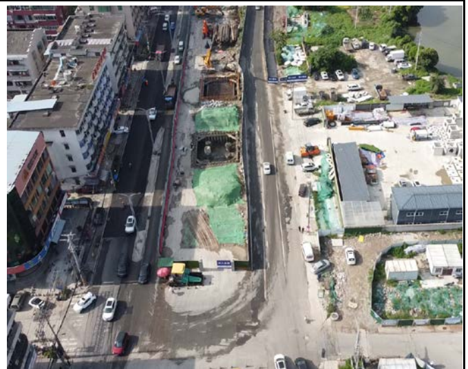
承台施工、土方临时遮盖（3 标）（2021.06）
