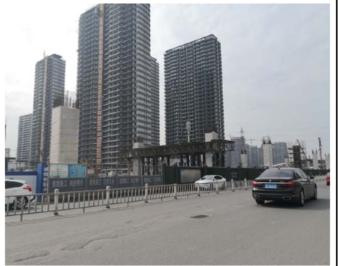
盖梁施工及周边地面道路（2021.12）
