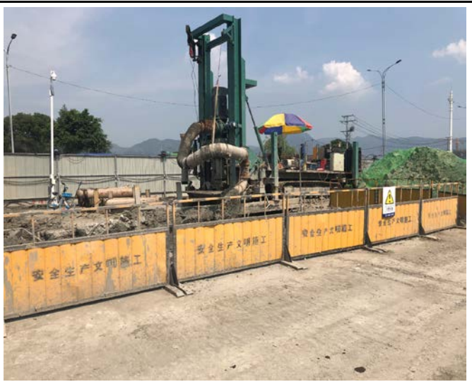
桩基施工、临时堆土（2020. 09）
