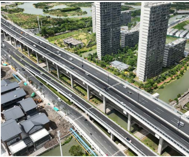
主线高架桥、匝道桥及桥下空间（2标）（2023.12）
