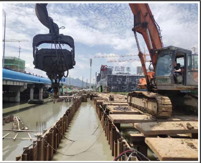
河道围堰施工（2020.03）
