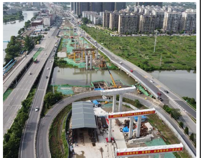
3 标地上部分施工 (2021. 03)
