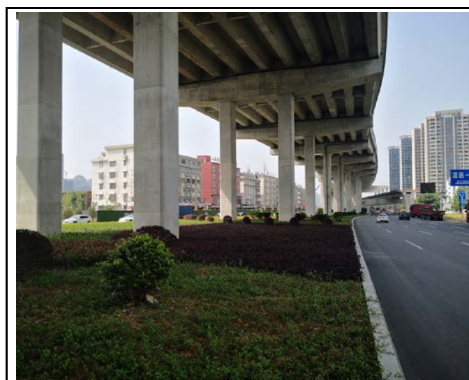
道路路面及桥下绿化 (2023.06)
