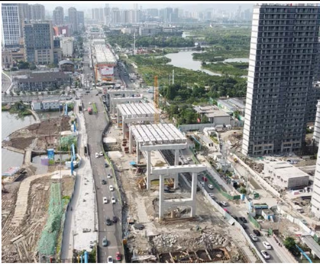
施工整体面貌（2 标）（2021.06）
