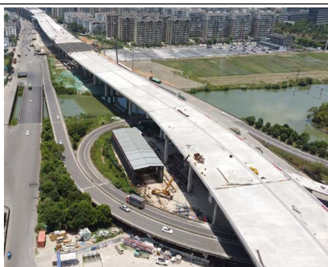
3 标施工整体面貌（2022.06）
