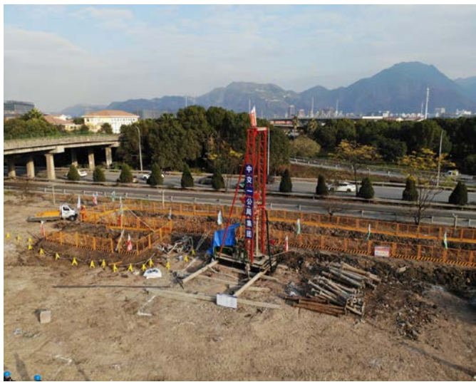
桩基及泥浆池（2020. 09）
