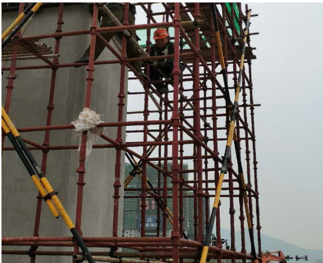
主线高架桥立柱施工（2020. 09）
