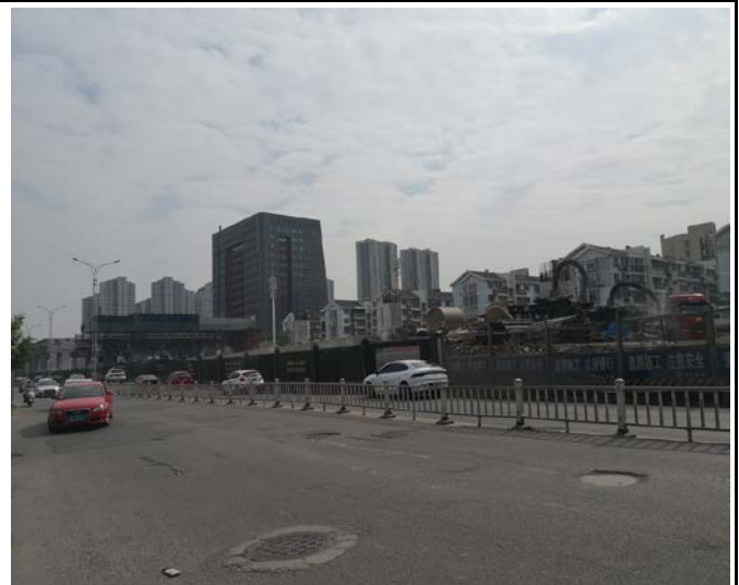
施工地面道路（2021.12）
