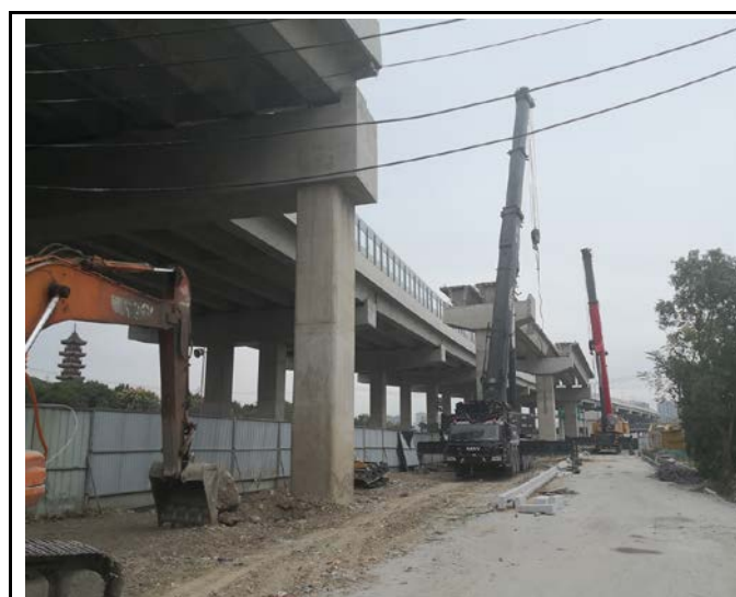
匝道箱梁施工（2022. 12）
