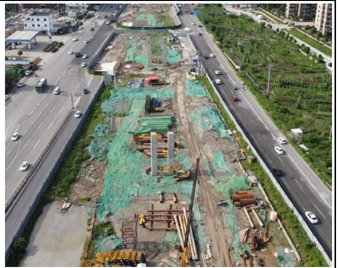
承台立柱施工（3 标）（2021.06）
