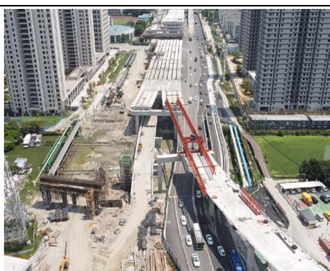
高架桥、地面桥施工（1标）（2022.06）
