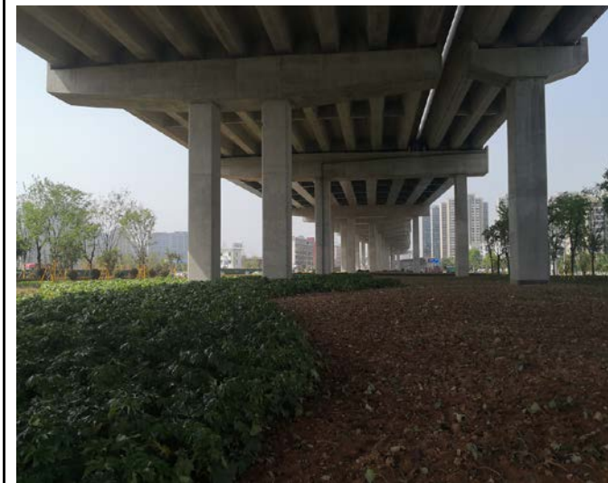
桥下绿化施工（2023. 06）
