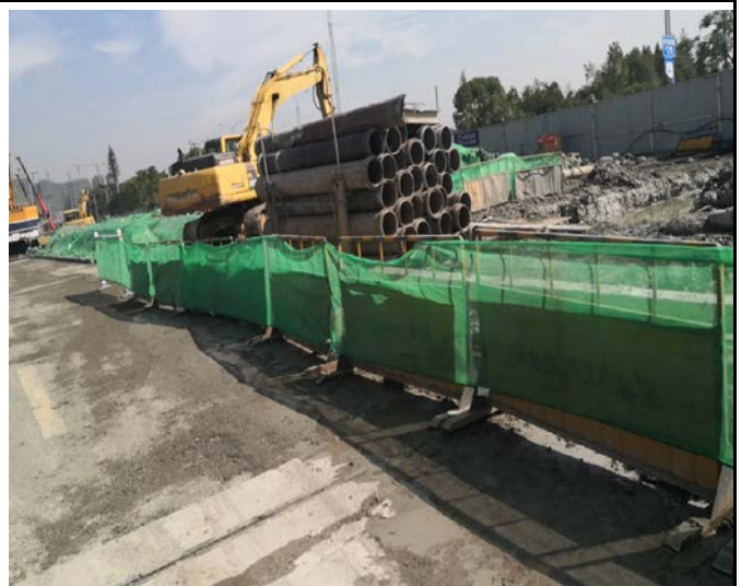
临时围挡及遮盖措施（2020.03）
