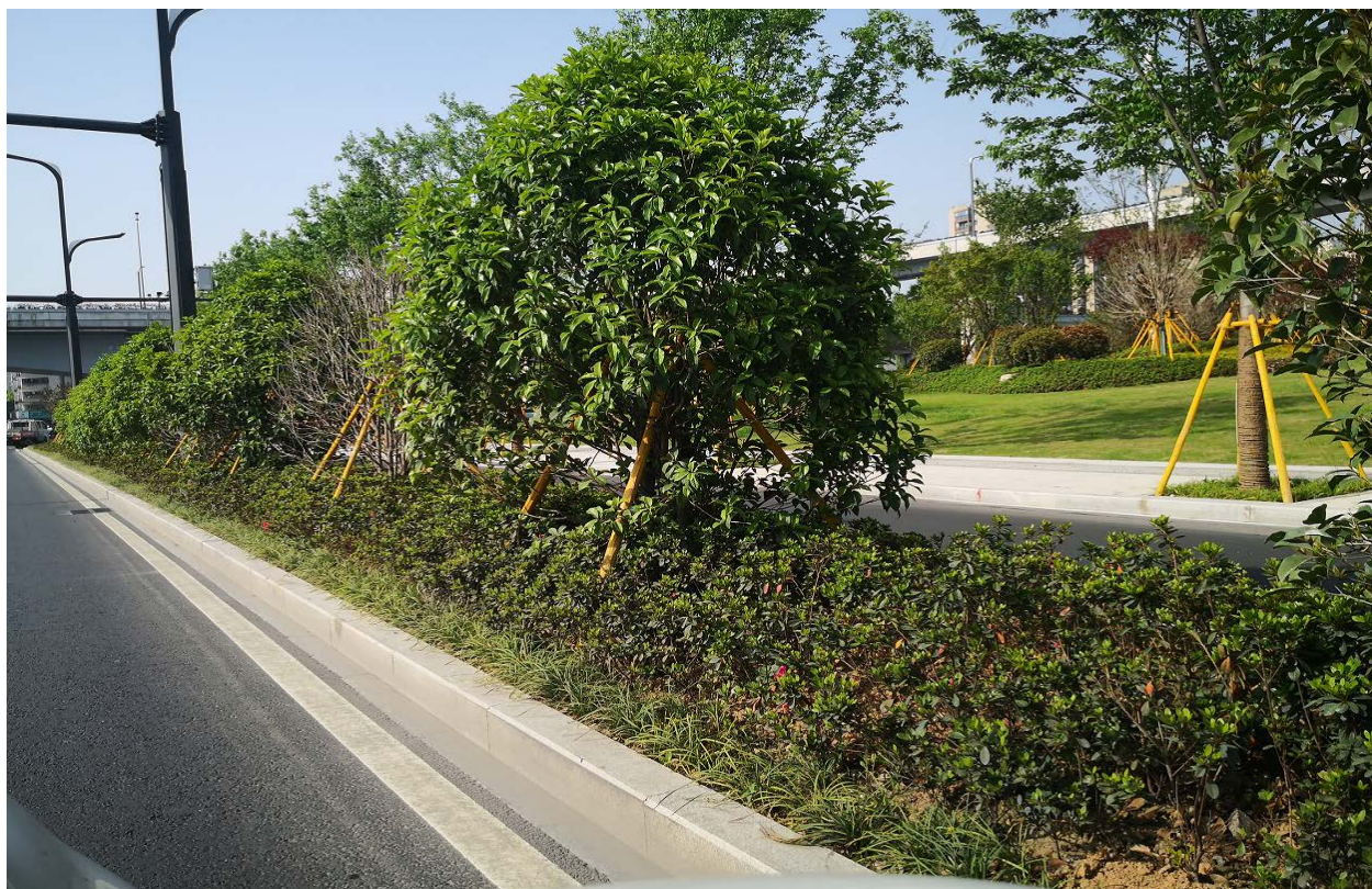
图4-4 机非分隔带绿化
