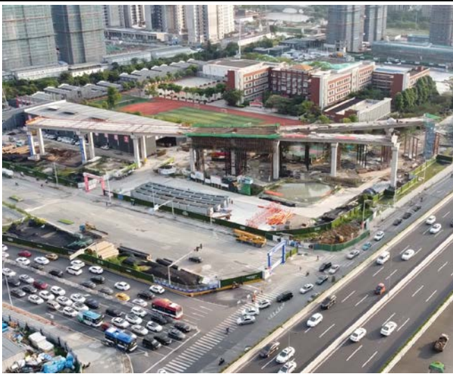
互通匝道施工（1标）（2021.06）
