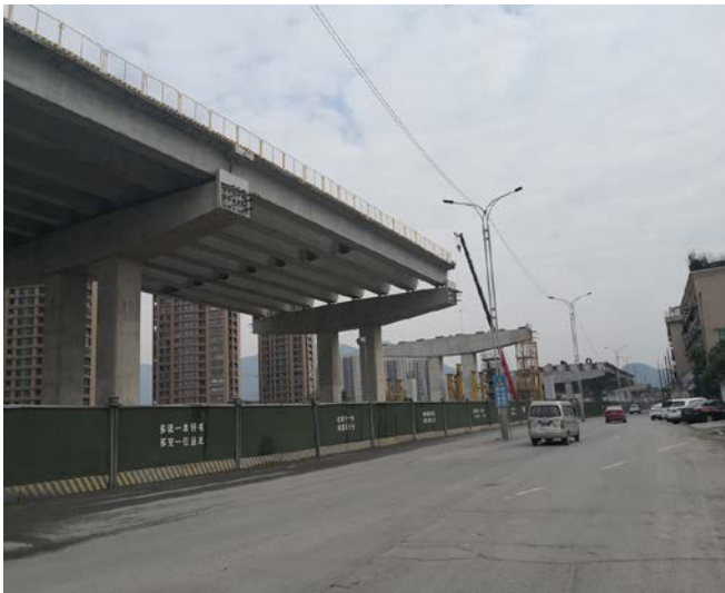
主线高架桥施工及地面道路（2021.12）
