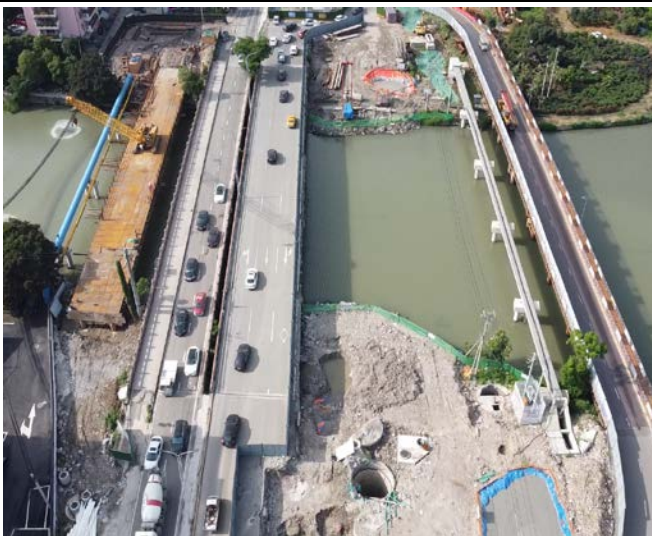
临时便桥、管线工程施工（3 标）（2021.06）
