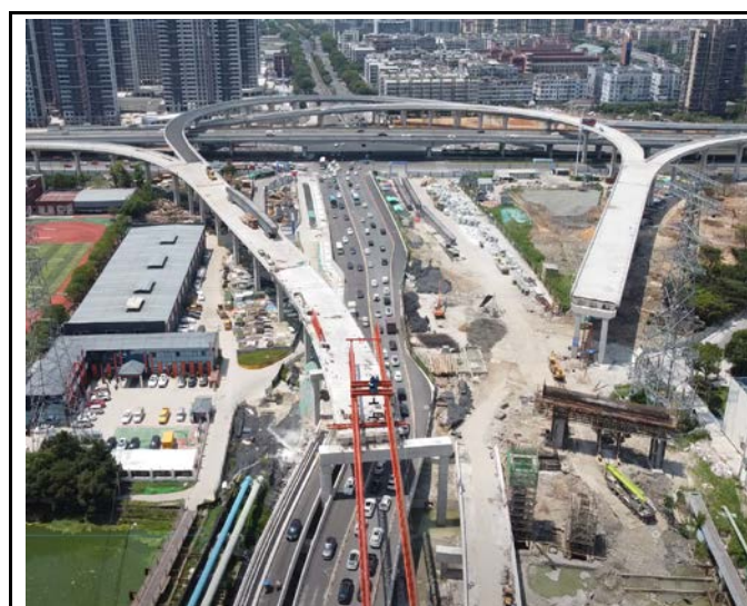
瓯海大道互通匝道施工（1标）（2022.06）
