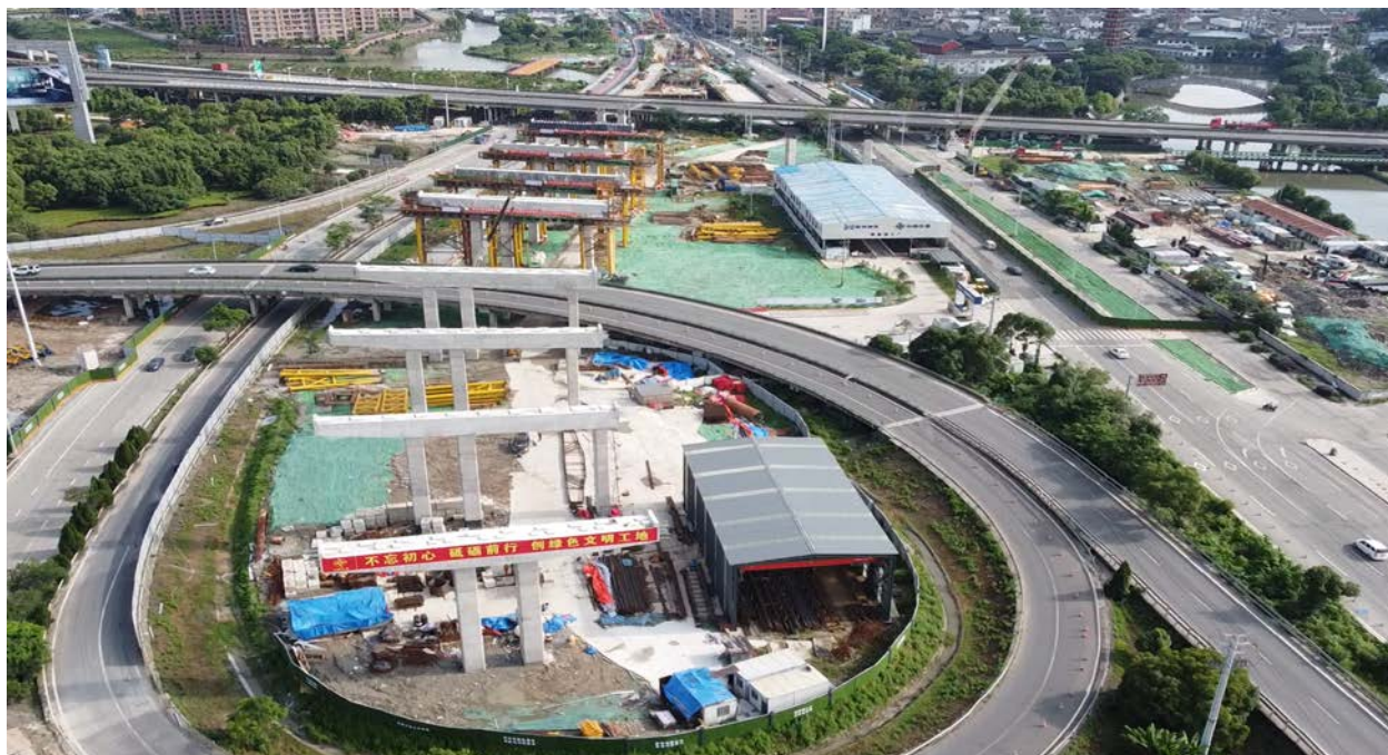
图3-4 钢筋加工棚等布置在互通红线范围内
