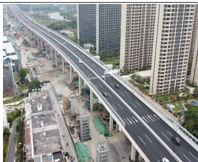
高架桥通车及桥下空间（2022. 12）
