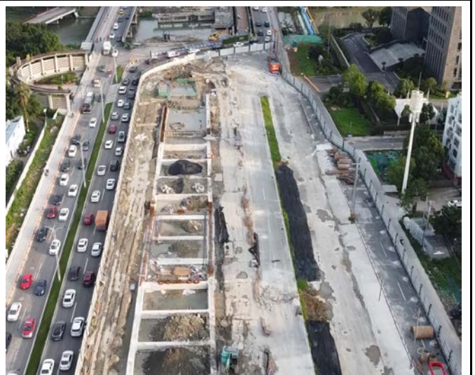
基坑冠梁施工（1标）（2021.06）
