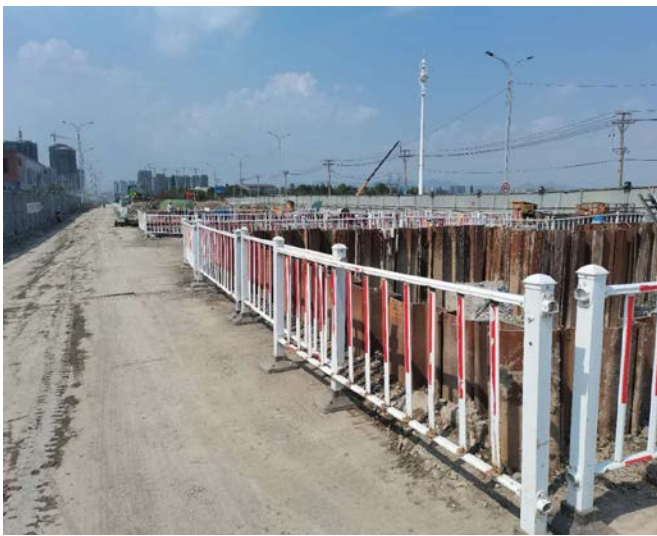
承台基坑围护及临时堆土（2020. 09）
