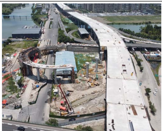
主线桥、NE 匝道施工（3标）（2022.06）
