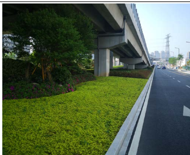
地面道路及匝道桥下绿化（1 标）（2023. 12）
