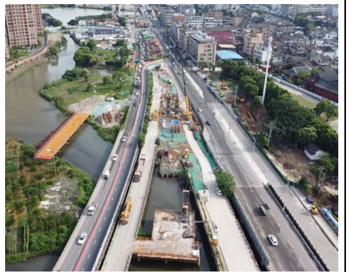
终点处施工现状（3 标）（2021.06）
