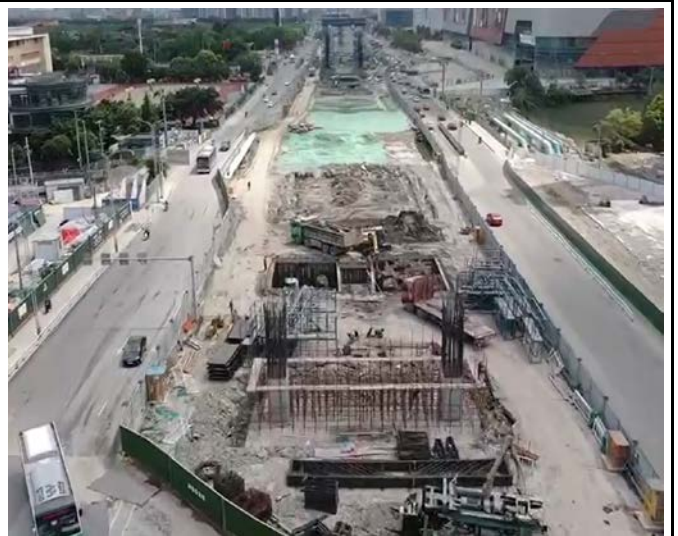
承台施工（周边布设有围挡）（2标）（2021.06）
