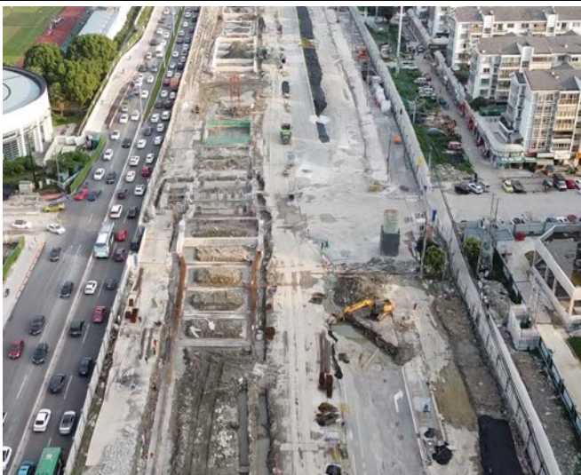
1 标 S3 线基坑围护施工（2021.03）
