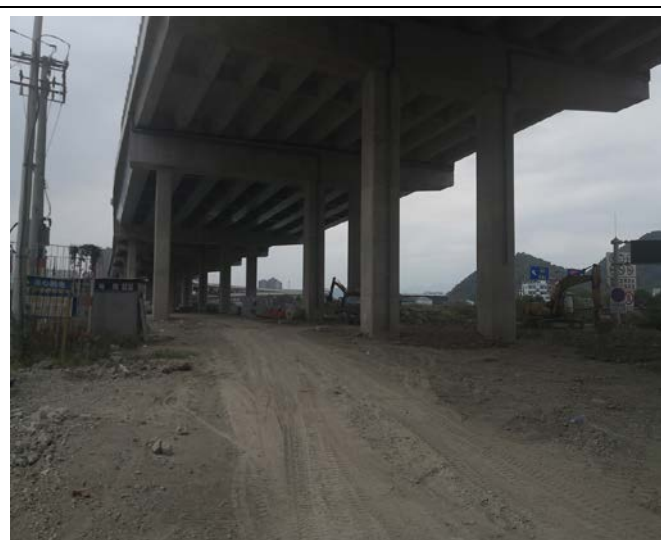
主线高架施工（2022. 12）
