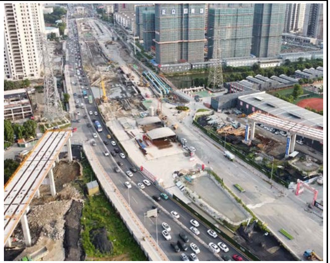
施工整体面貌（1标）（2021.06）
