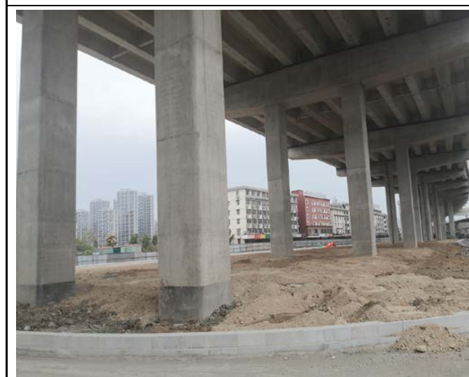
主线高架桥桥下（2022. 12）
