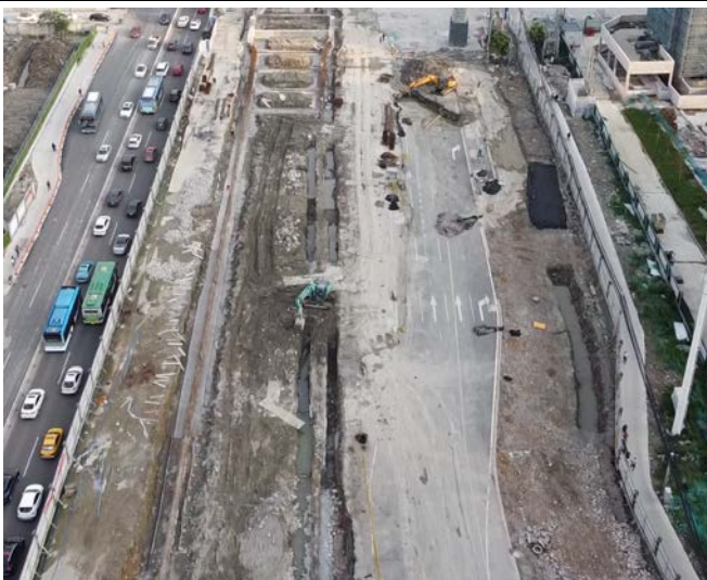
S3线基坑施工（1标）（2021.06）
