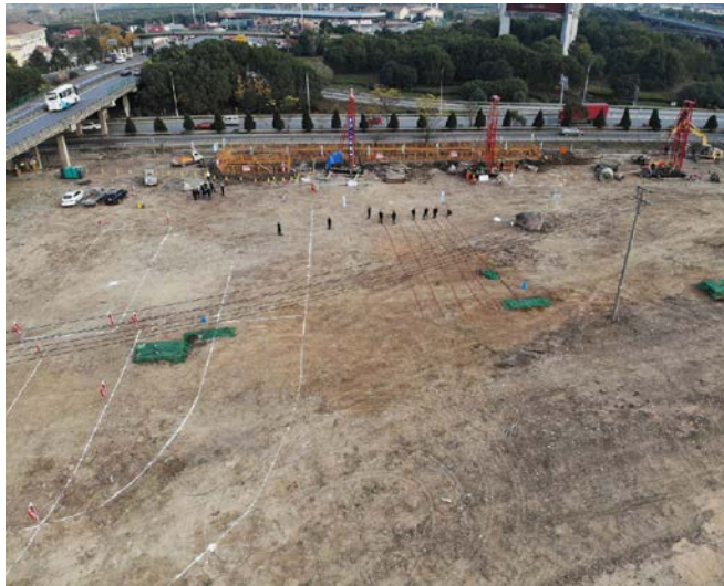
施工临时设施布设（2020.03）
