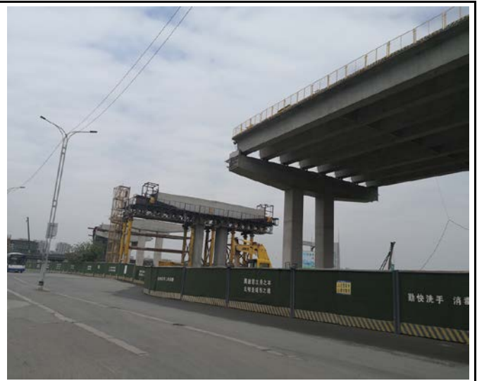
盖梁施工（两侧围栏）（2021.12）
