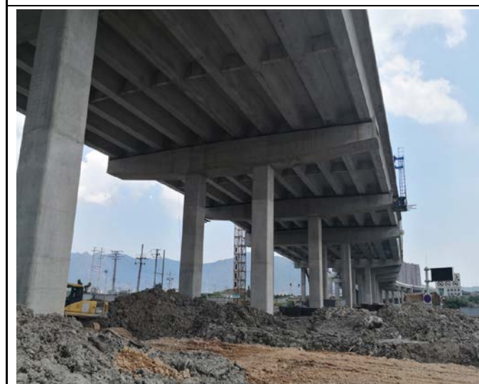
高架桥下临时堆土（2022.06）
