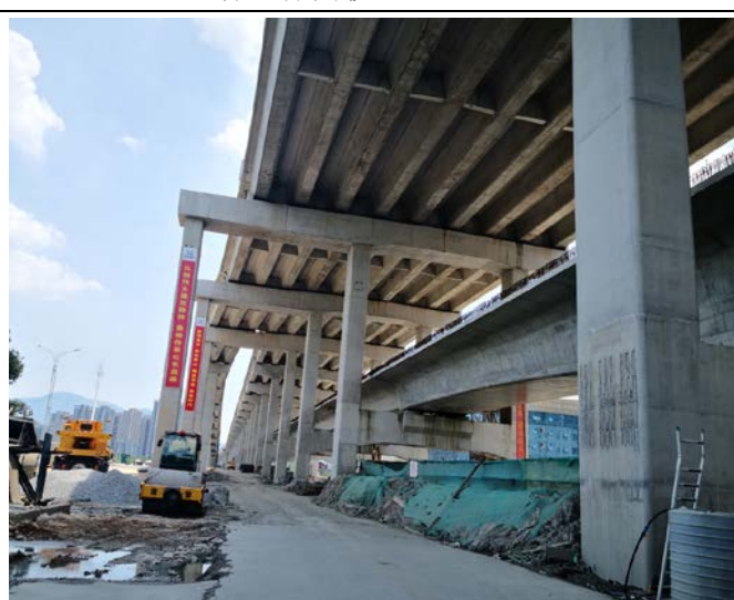
主线高架桥下空间及地面道路（2标）（2022.06）
