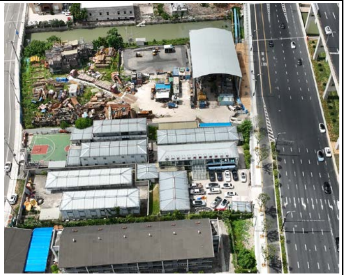
工程施工项目部（2023.12）
