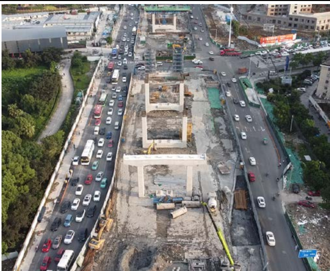
2 标地上部分施工（2021.03）
