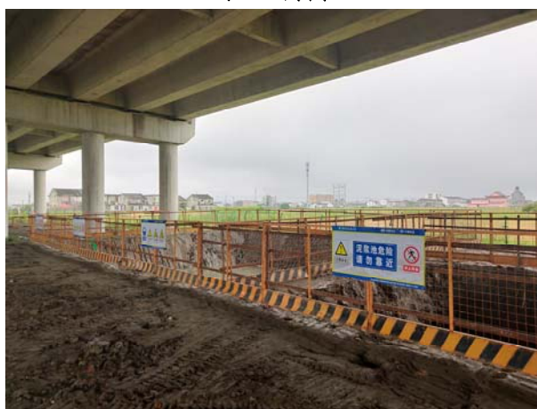
钻渣泥浆沉淀池
