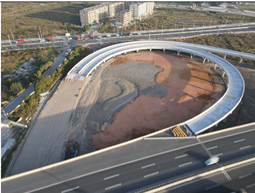
绿化覆土施工
