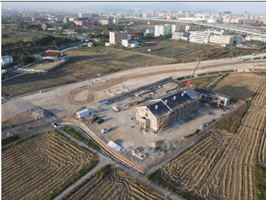
沿线设施施工
