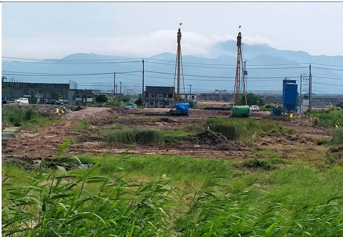
水泥搅拌桩施工
