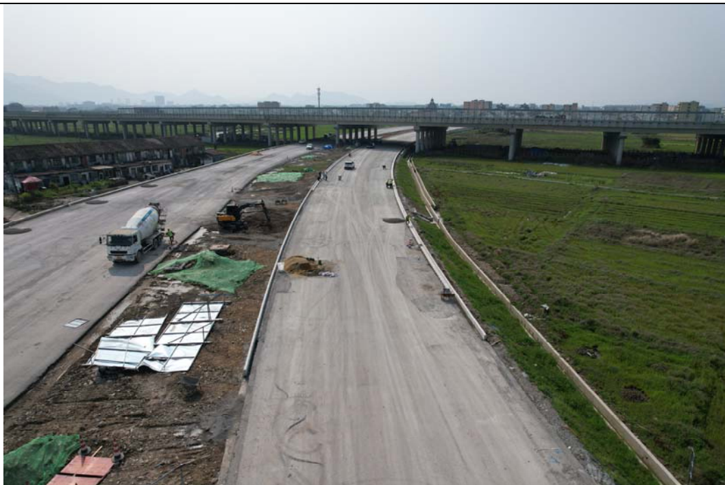
路面工程施工
