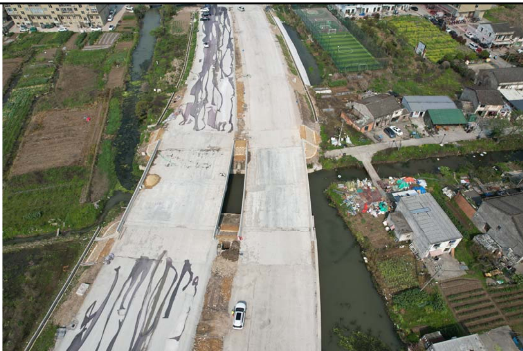
连接线桥梁工程
