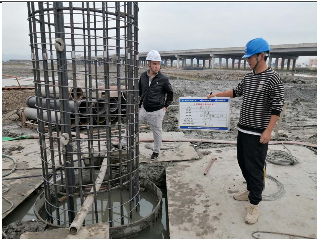
钻孔灌注桩施工
