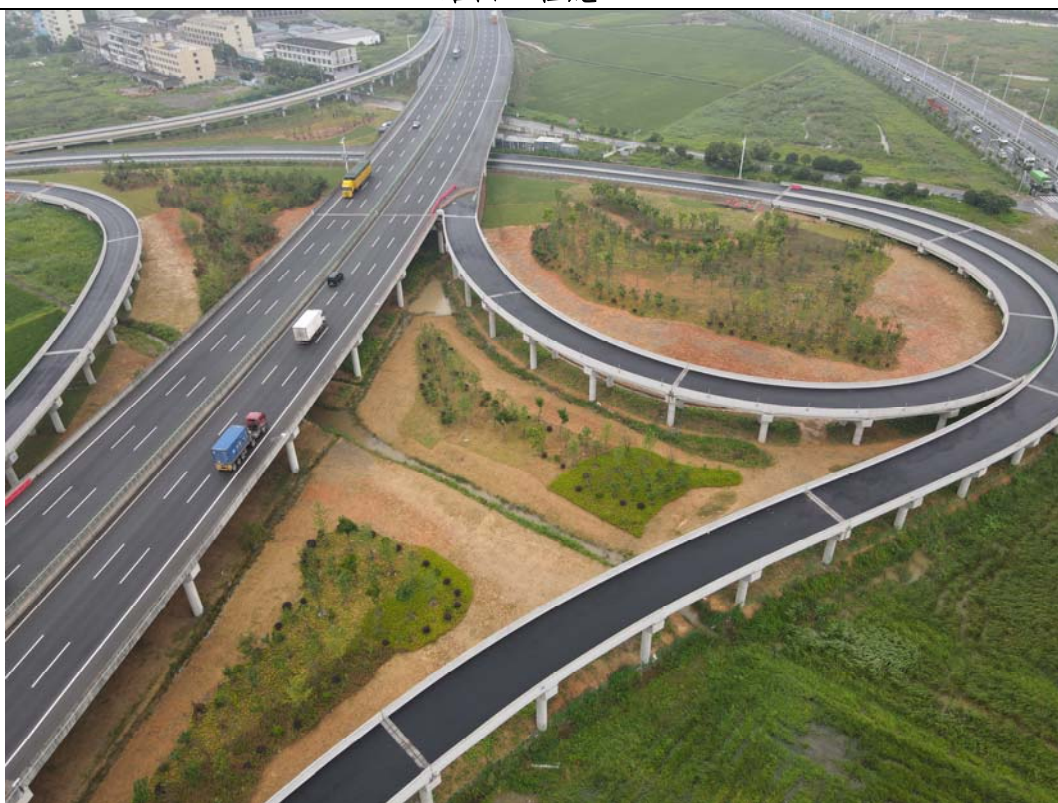
互通绿化施工
