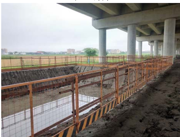
钻渣泥浆沉淀池
