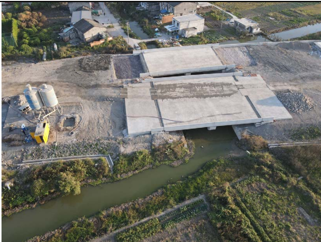
连接线桥梁施工
