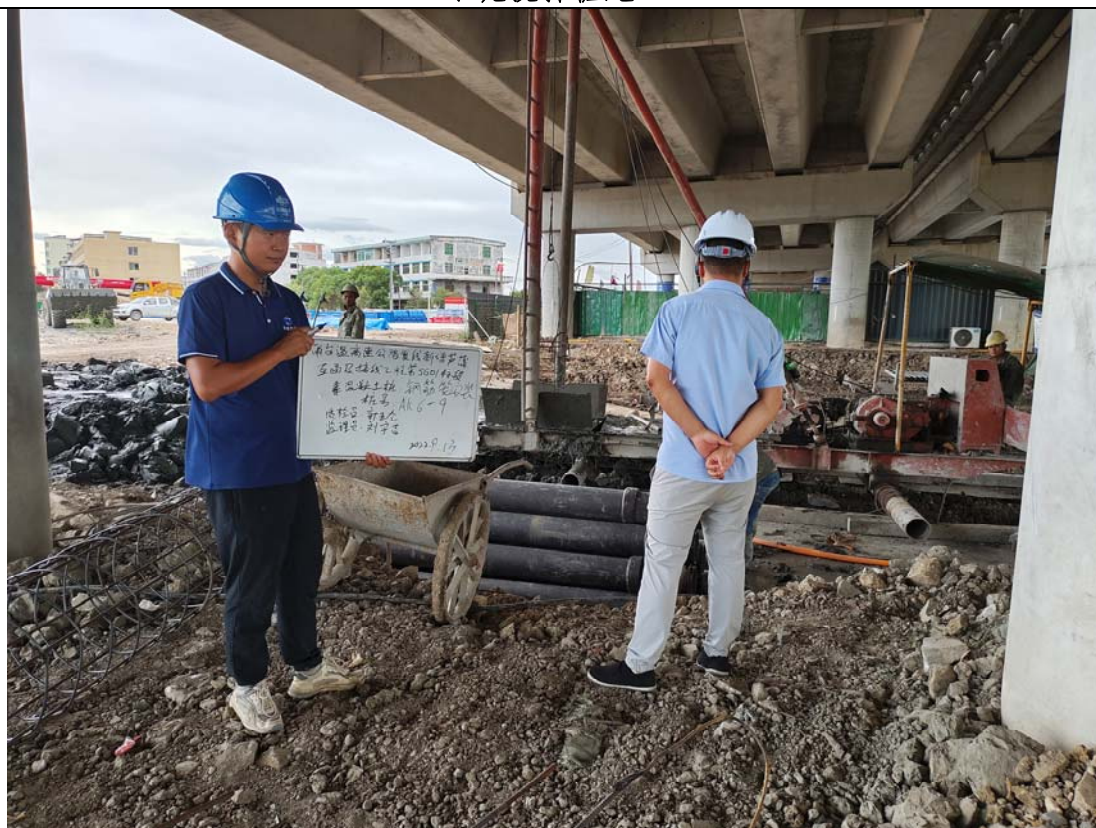
混凝土桩施工
