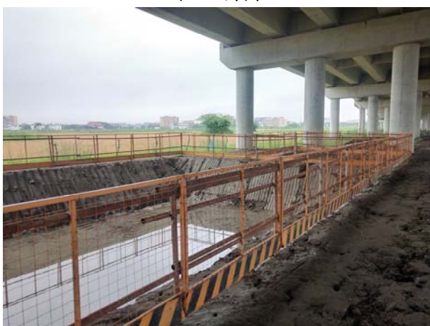
钻渣泥浆沉淀池
