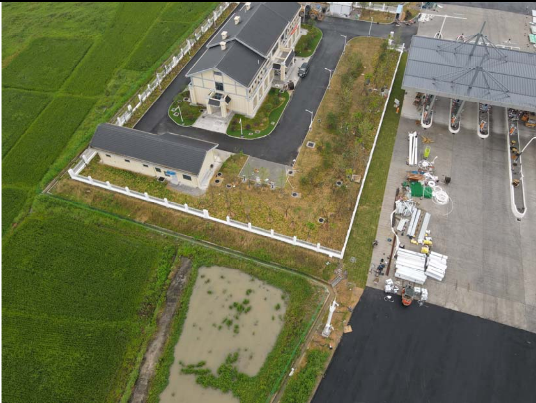
沿线设施绿化施工
