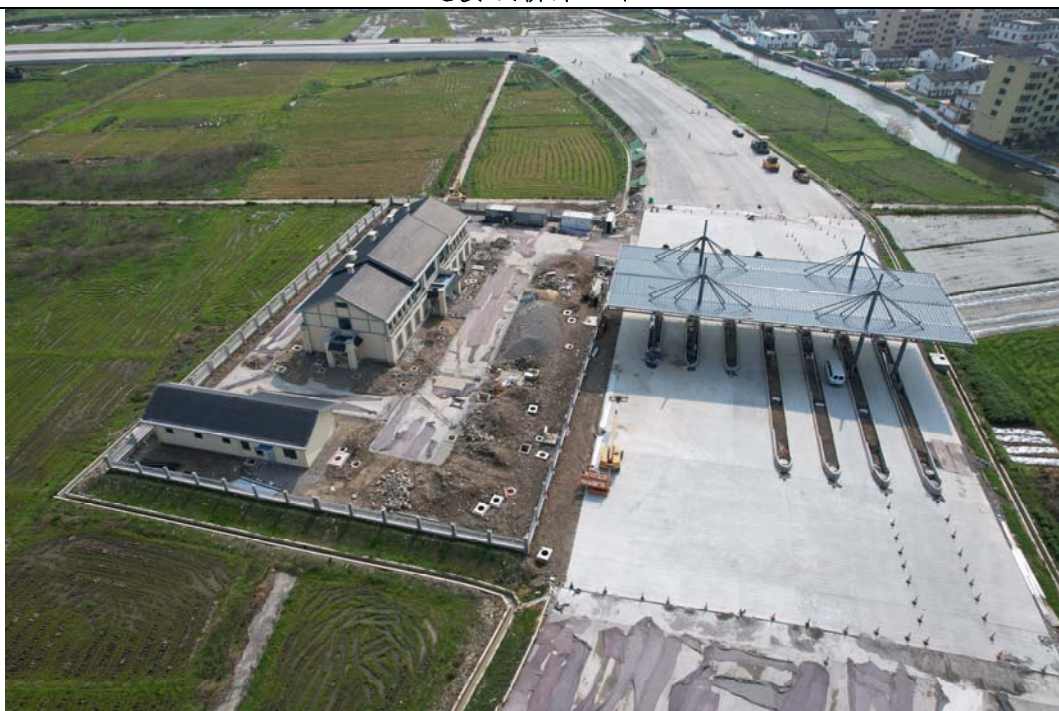
沿线设施施工
