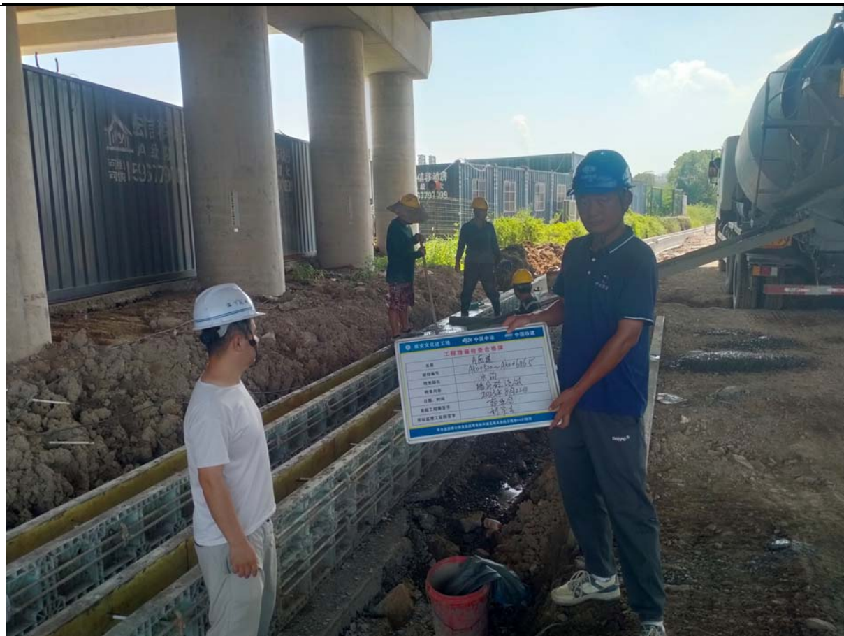
排水边沟施工
