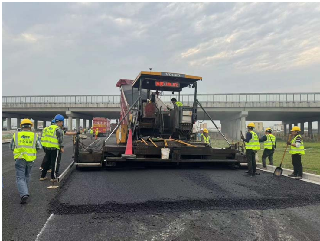
路面工程施工
