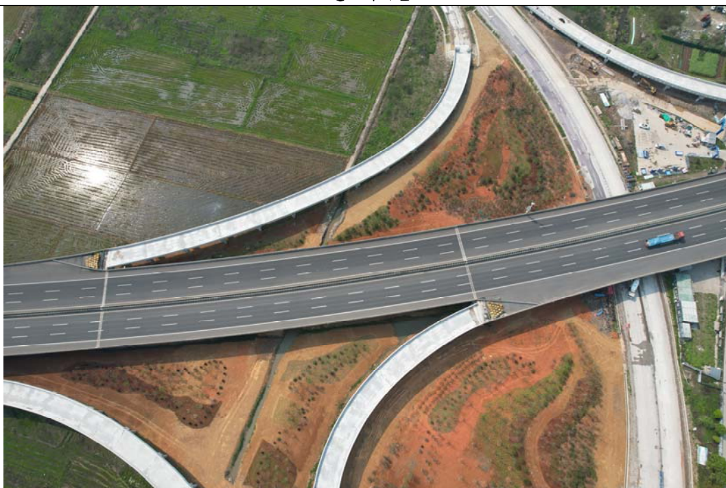
互通工程施工
