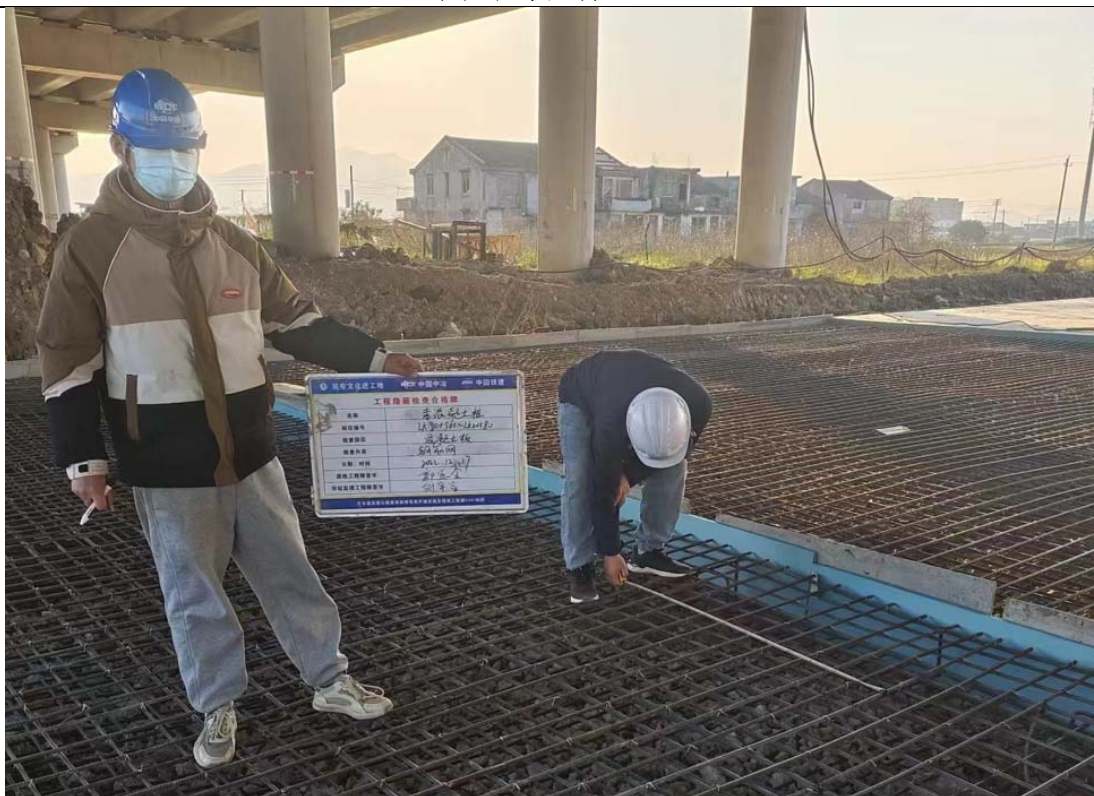
混凝土板施工
