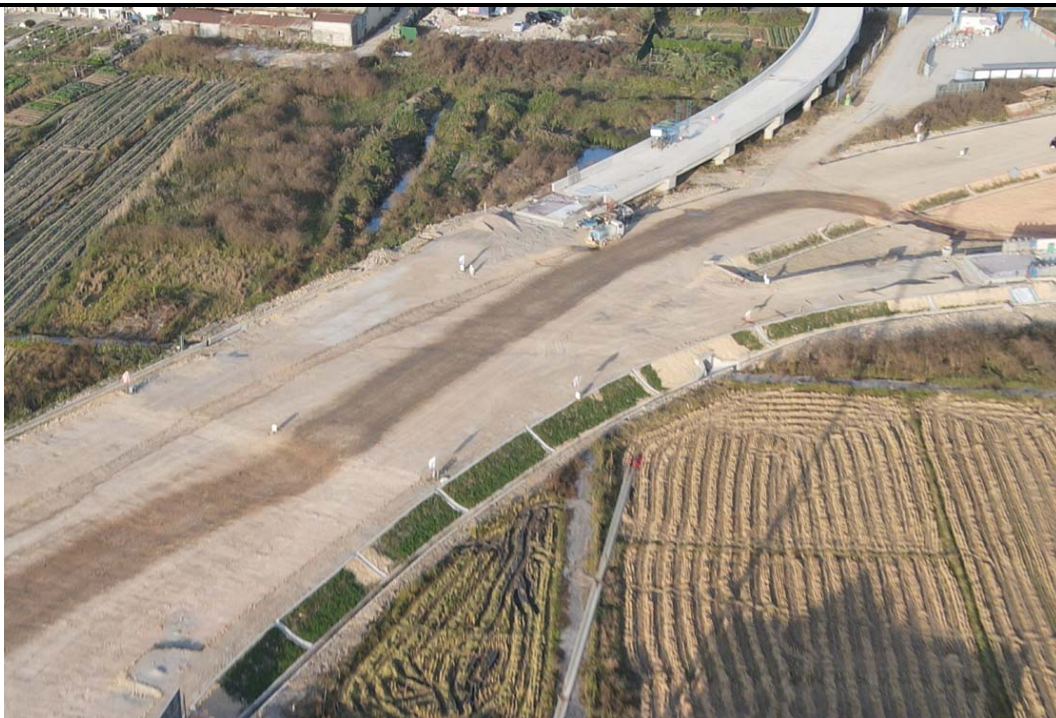
边坡防护施工
