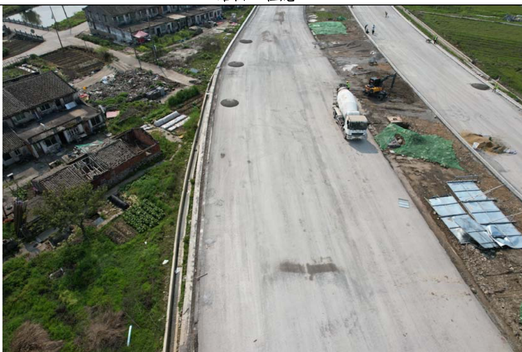
路面工程施工
