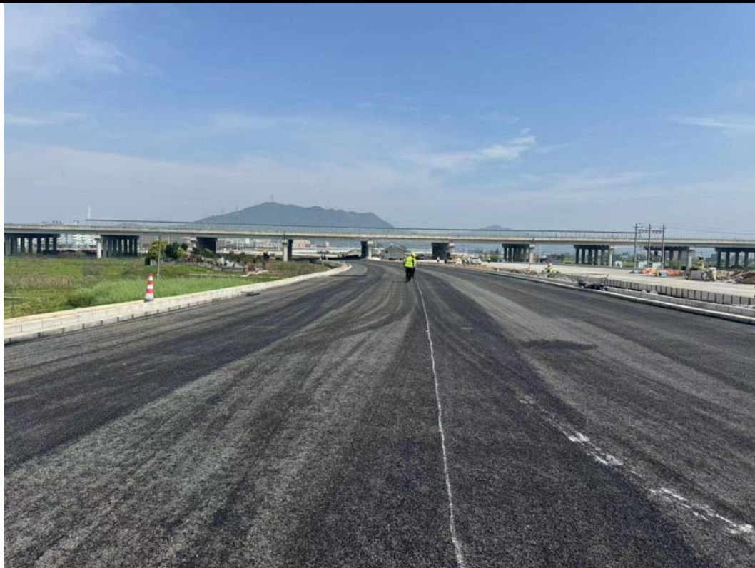
路面工程施工
