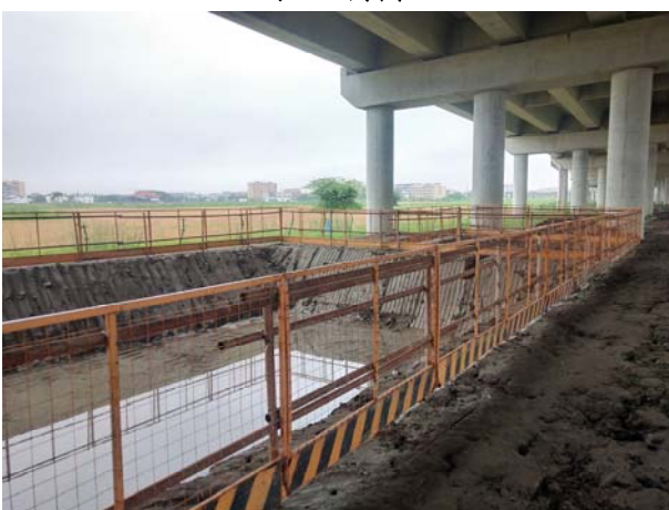
钻渣泥浆沉淀池
