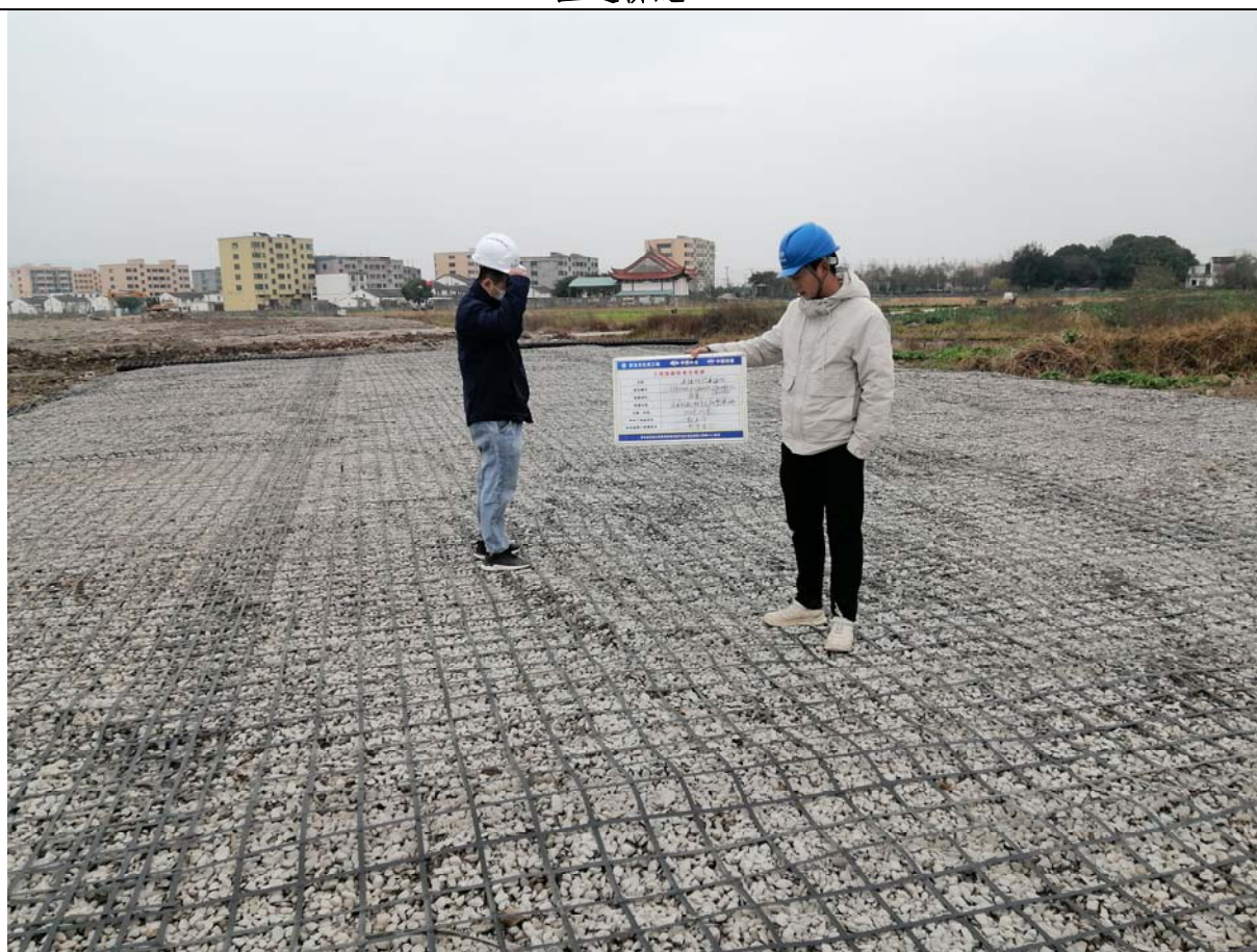
碎石垫层施工
