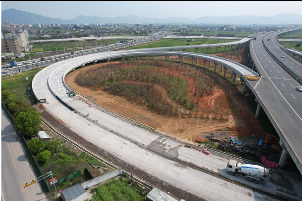
互通工程施工
