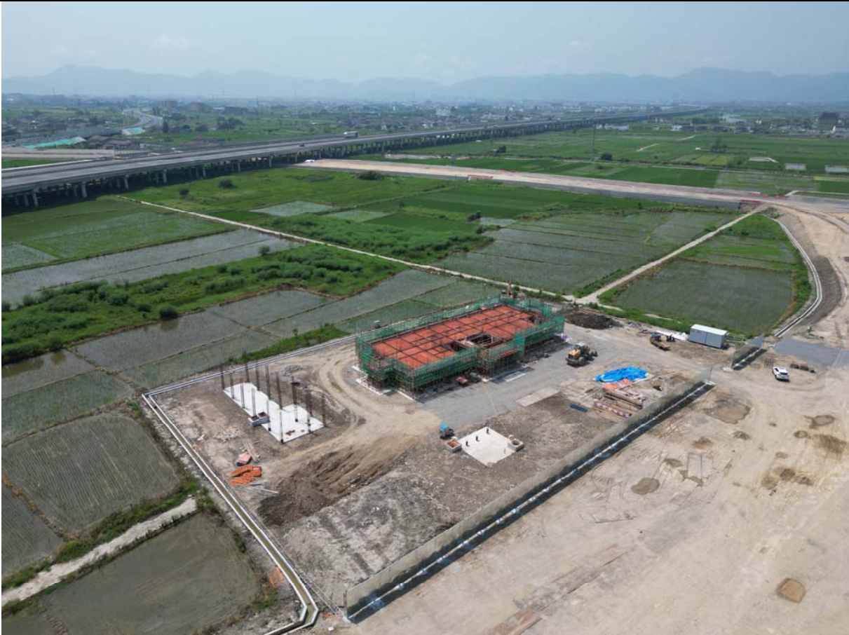
沿线设施施工
