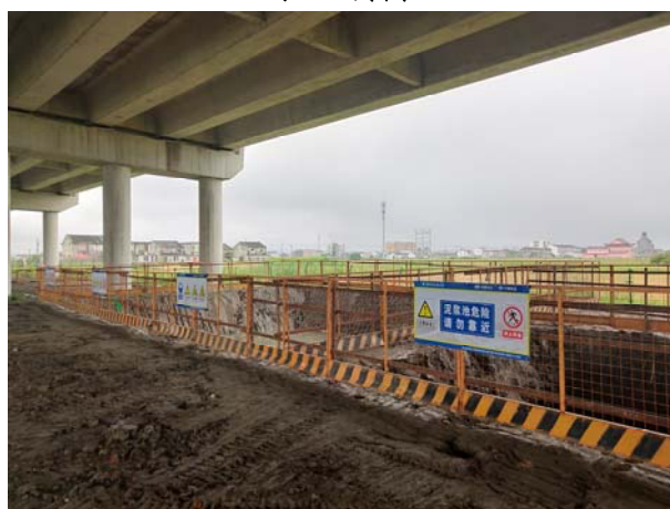
钻渣泥浆沉淀池
