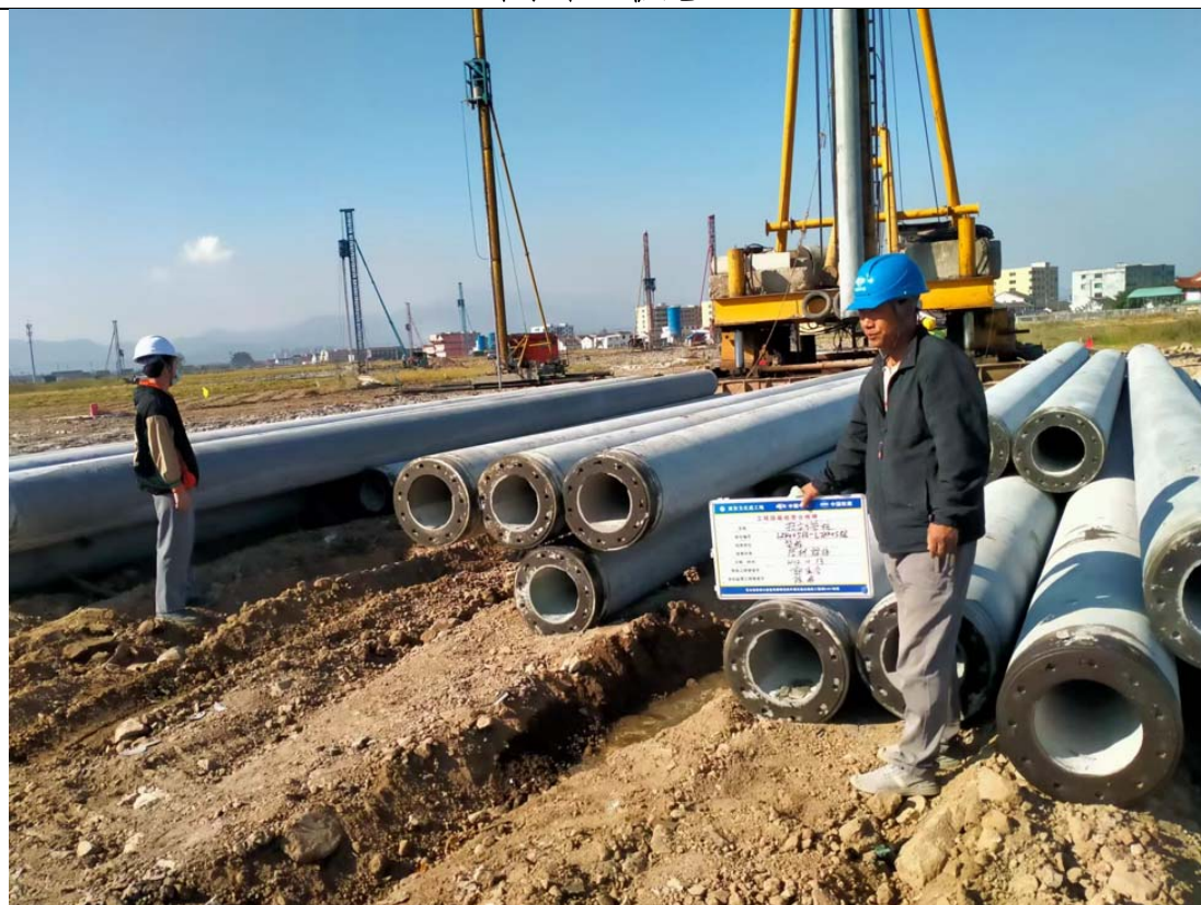
预应力管桩施工
