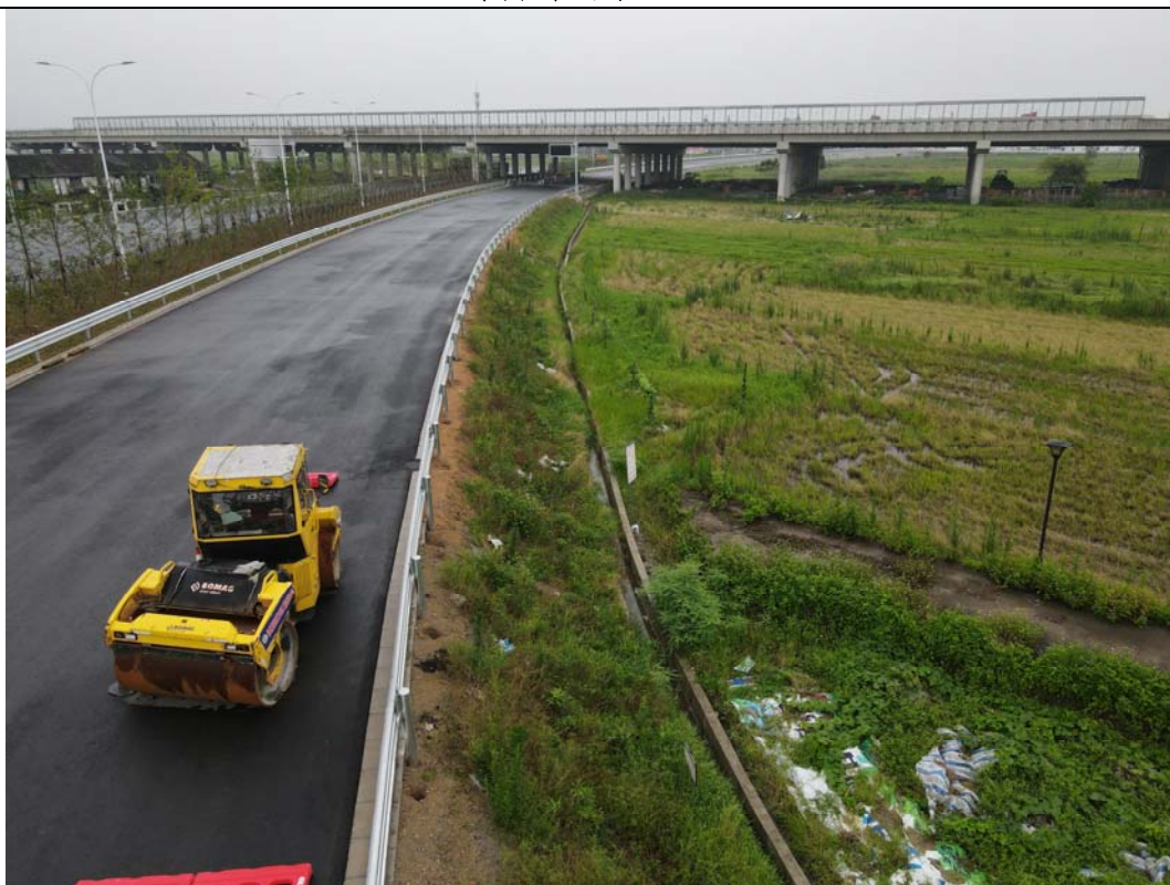
路堤边坡防护
