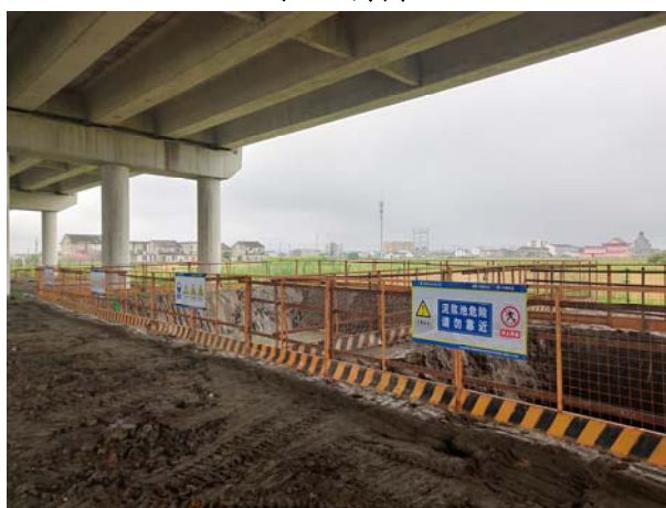
钻渣泥浆沉淀池
