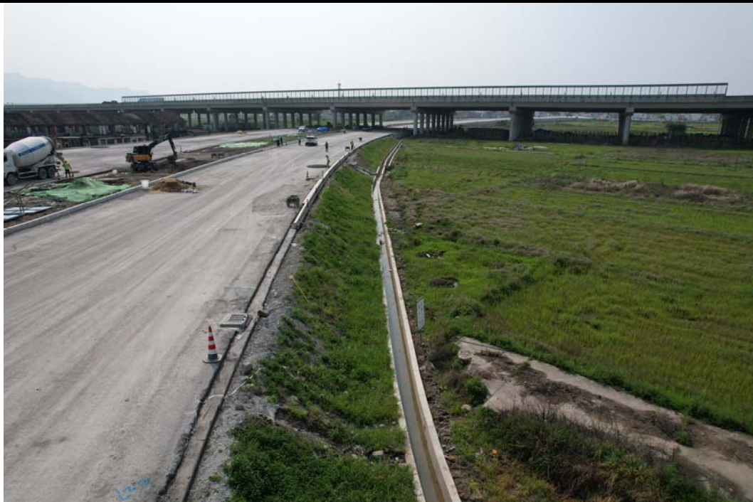
边坡防护施工
