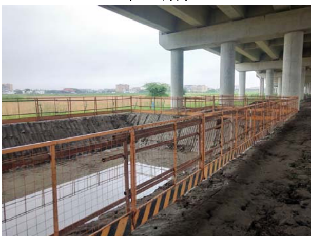
钻渣泥浆沉淀池
