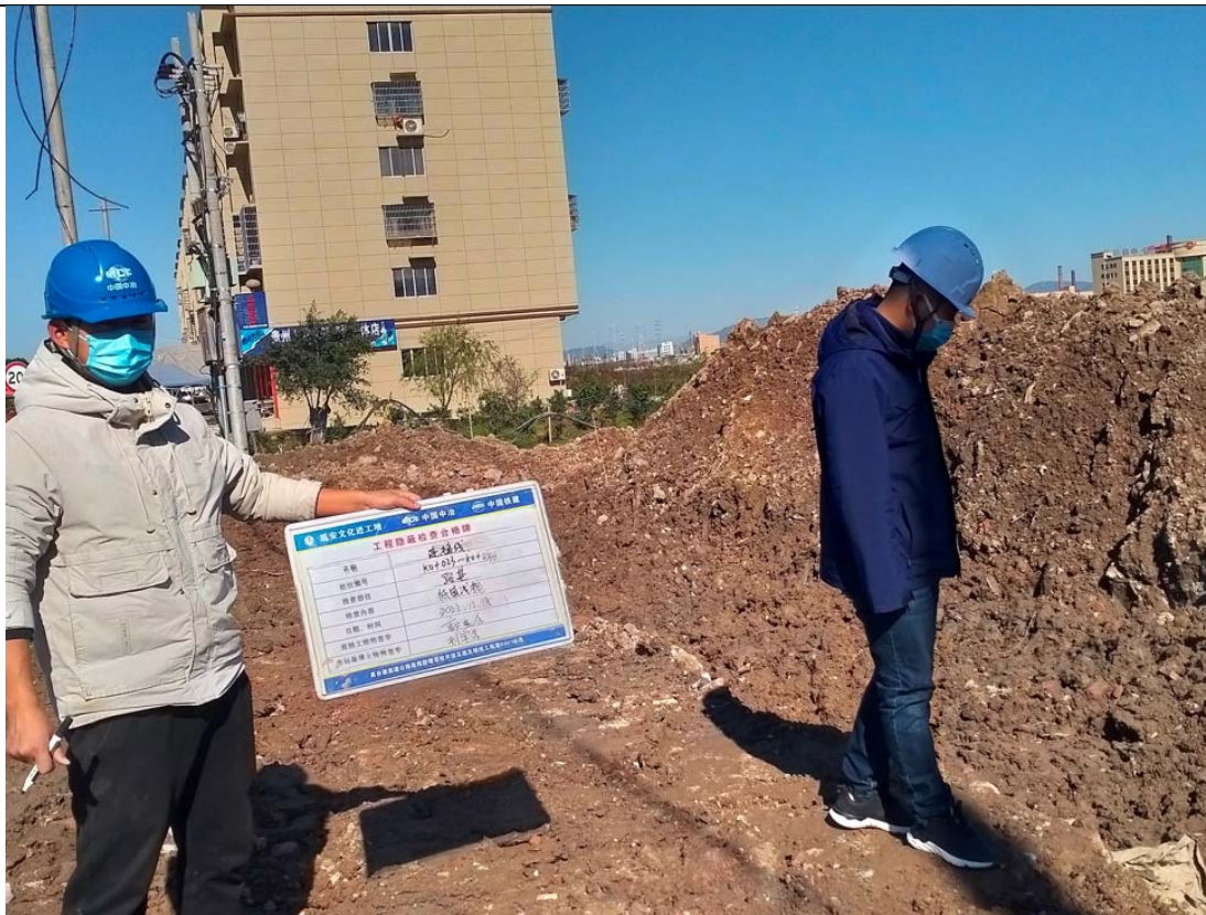
路基低填浅挖施工
