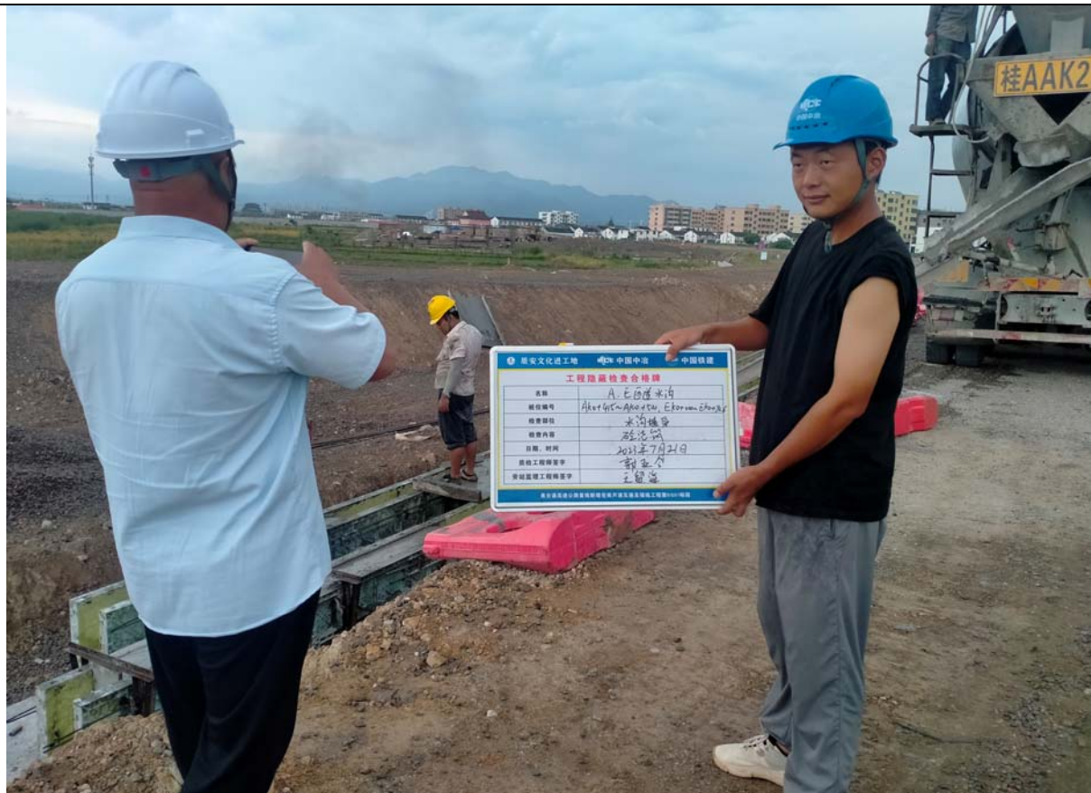
排水边沟施工
