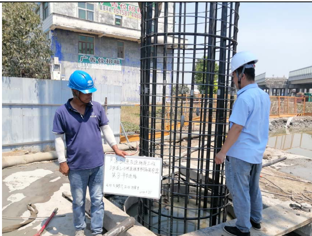
钻孔灌注桩施工
