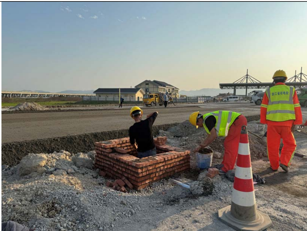
路面工程施工
