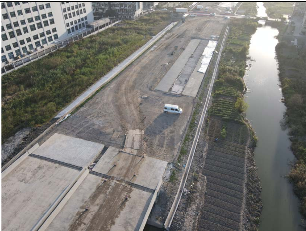
路面工程施工
