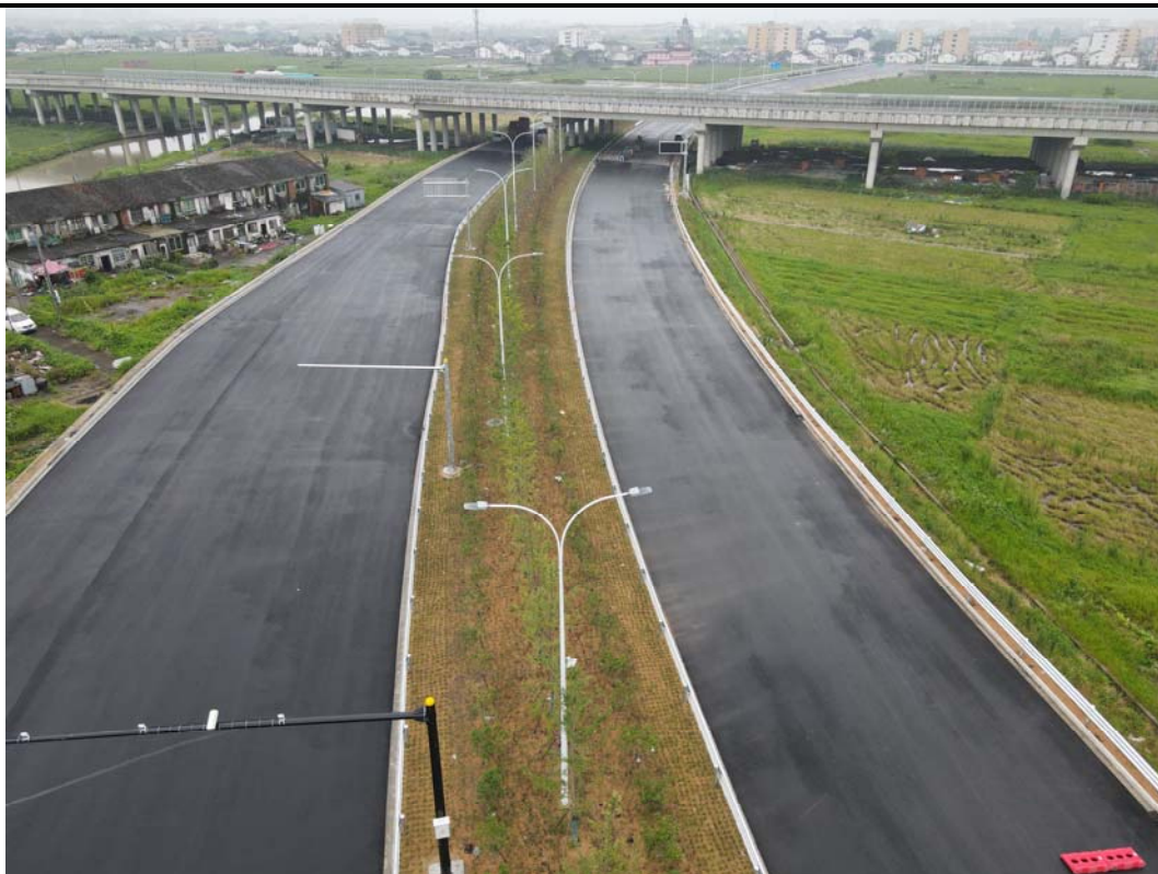
中分带绿化施工
