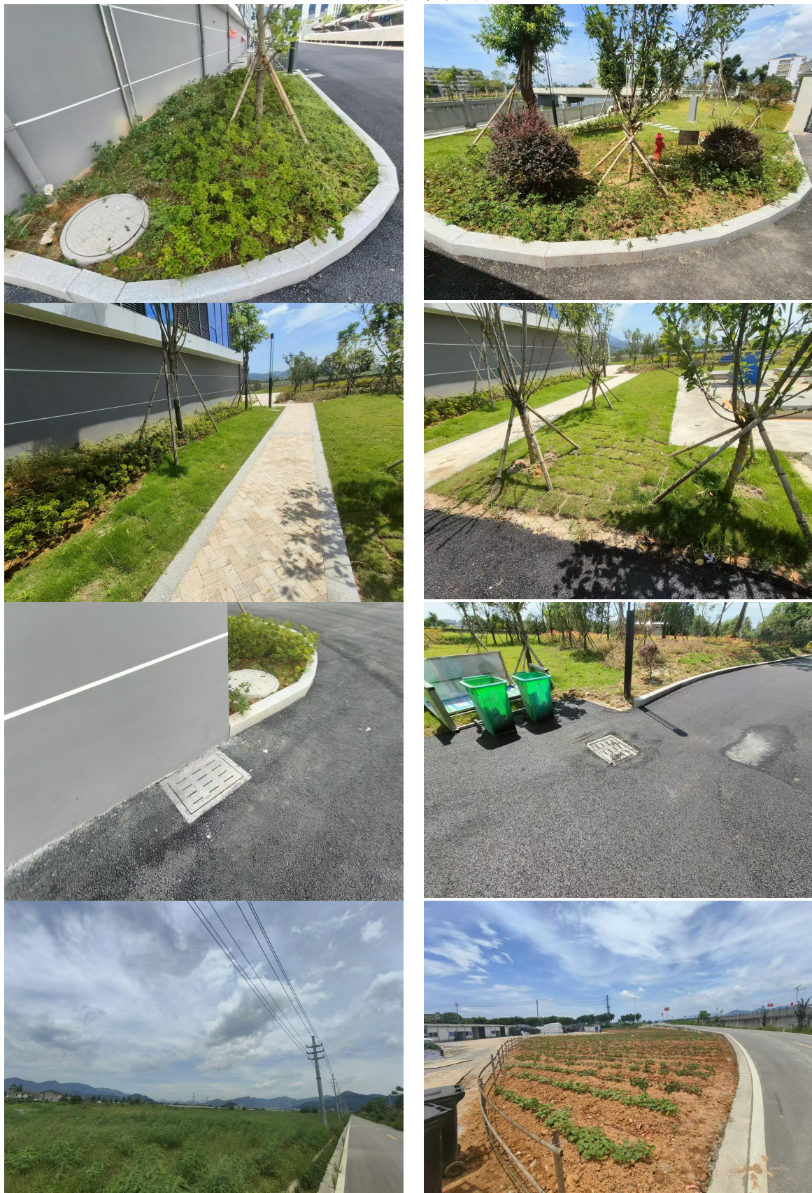
建筑物及硬质铺装
