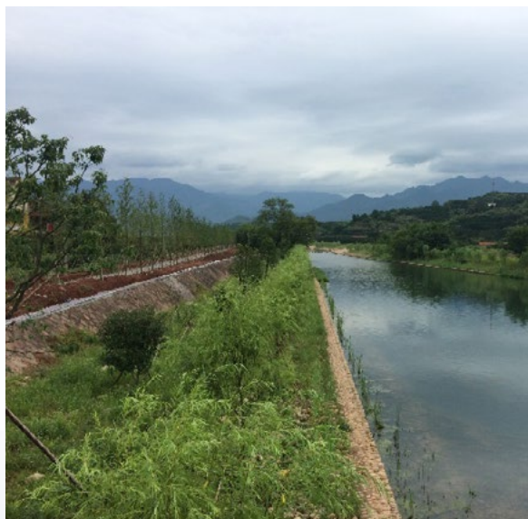
通过植物遮盖美化硬质护坡
