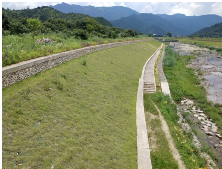
拆除老护坡重建
