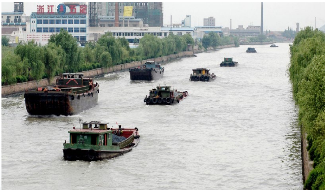
航道两岸护岸挡墙
