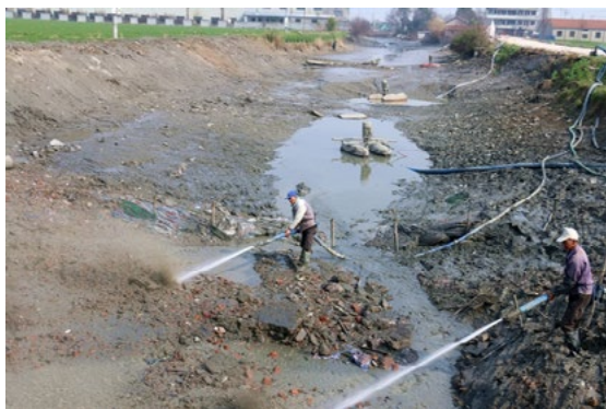
水力冲挖清淤
