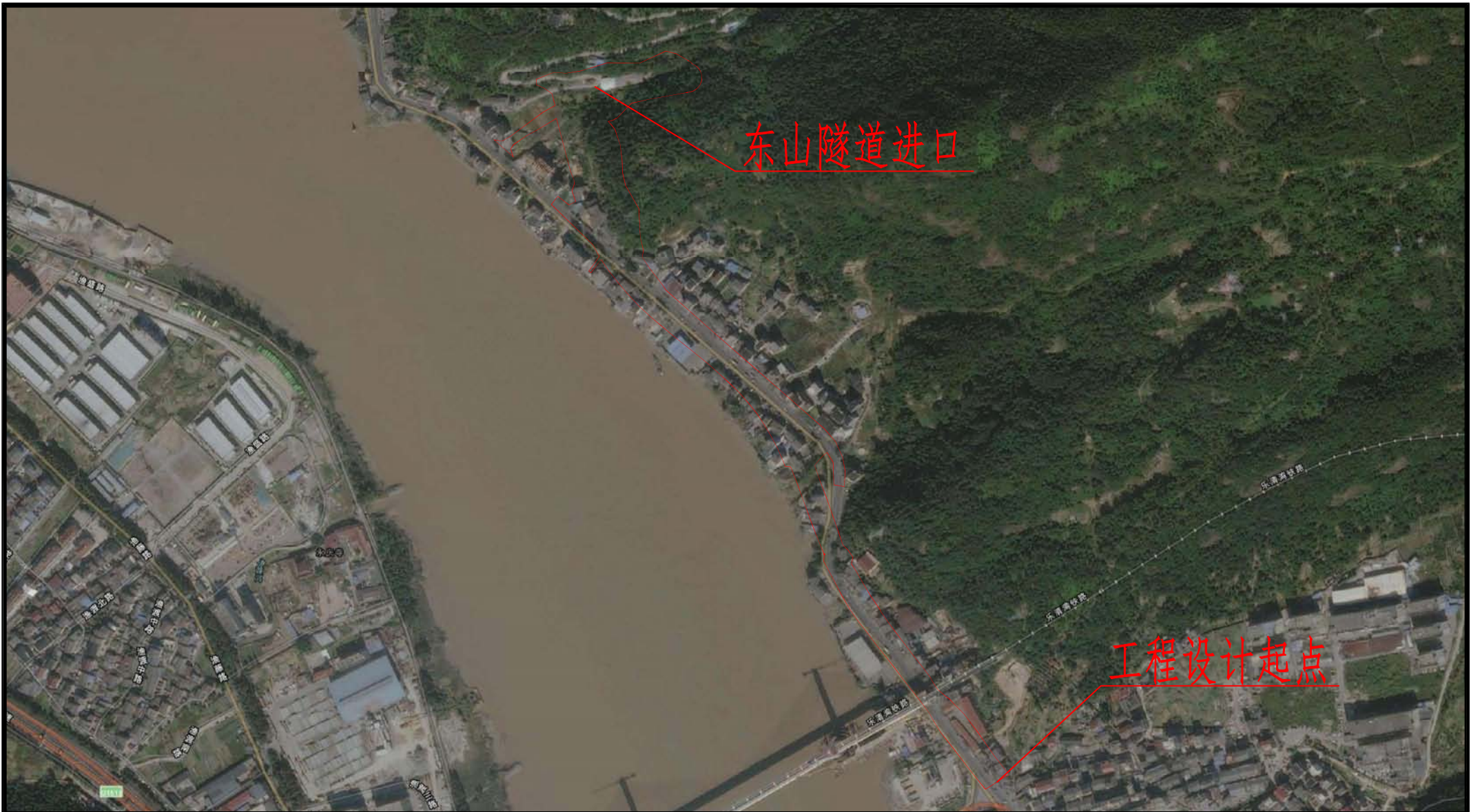
工程开工前遥感影像图
