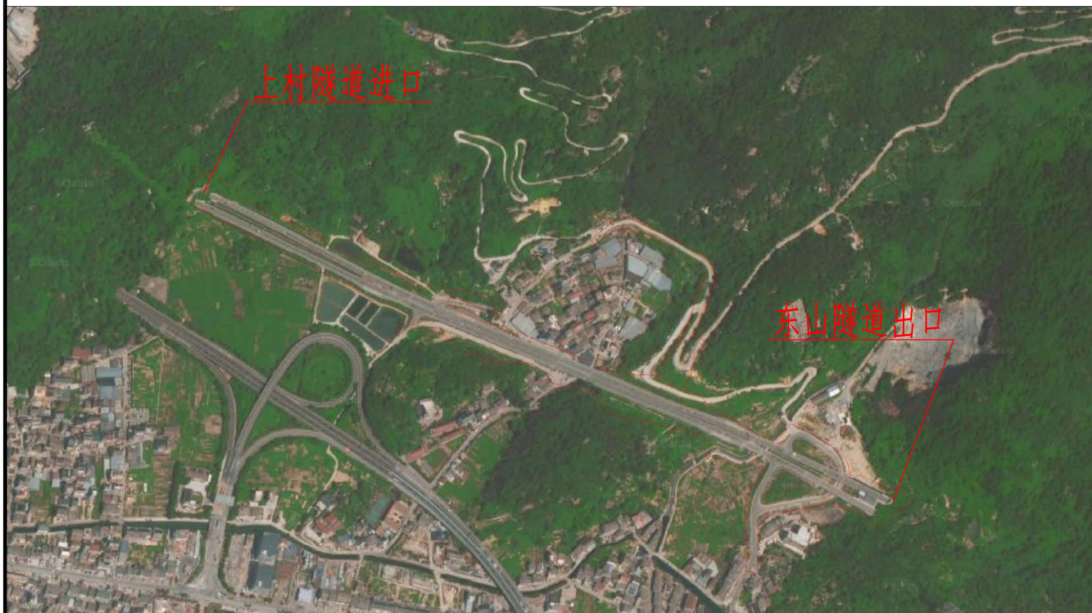
工程竣工后遥感影像图
