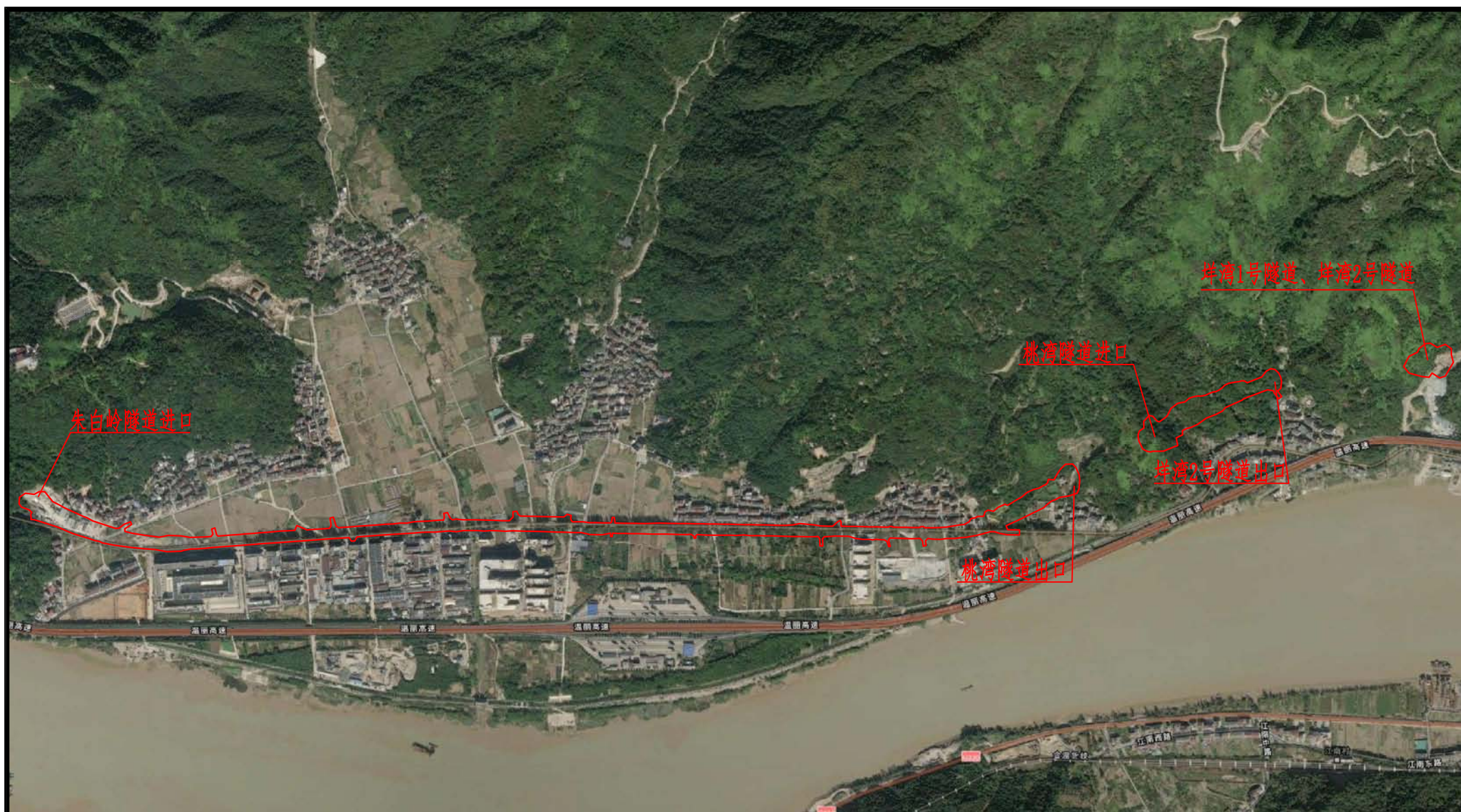
工程开工前遥感影像图
