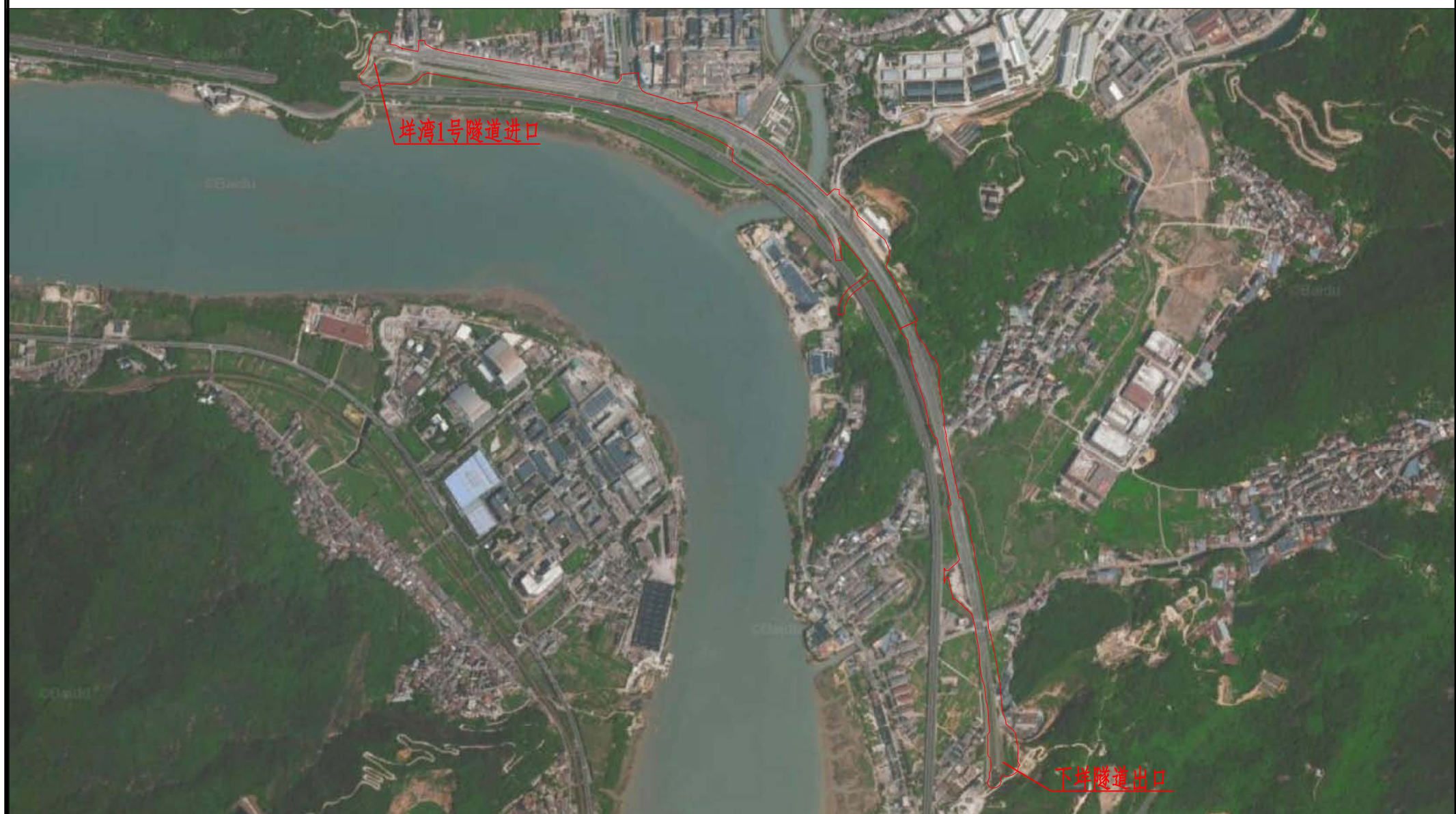
工程竣工后遥感影像图
