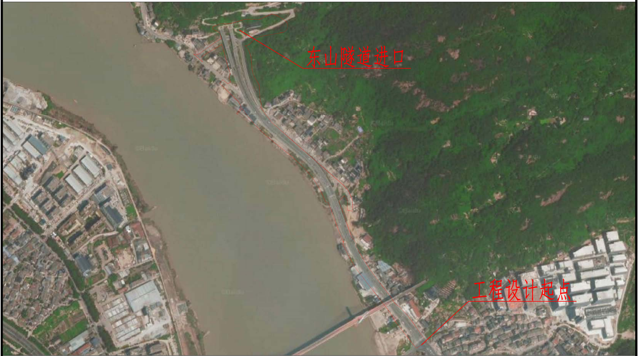
工程竣工后遥感影像图
