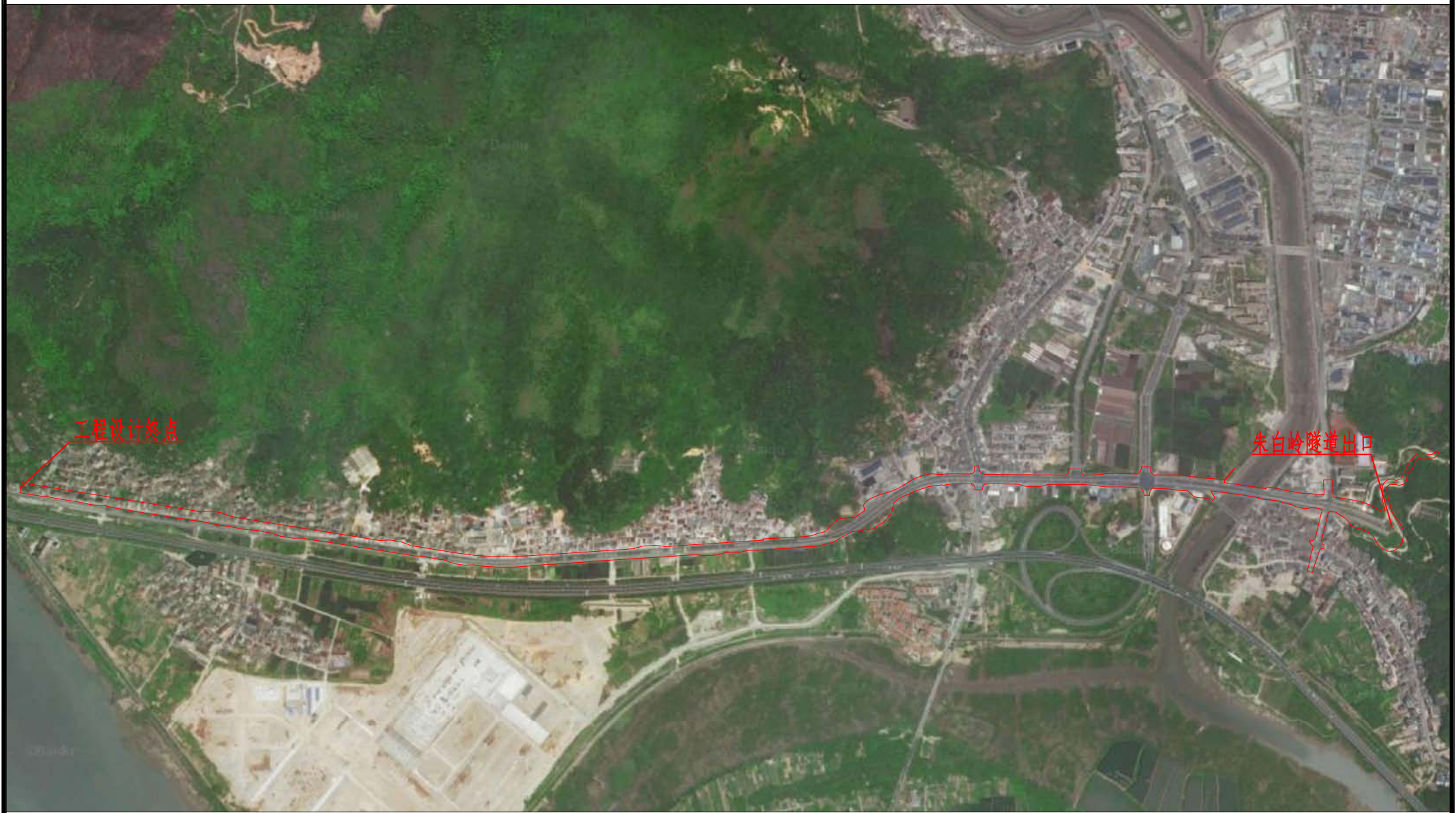
工程竣工后遥感影像图
