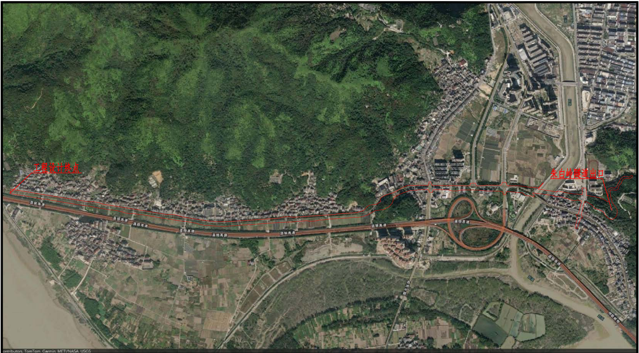
工程开工前遥感影像图
