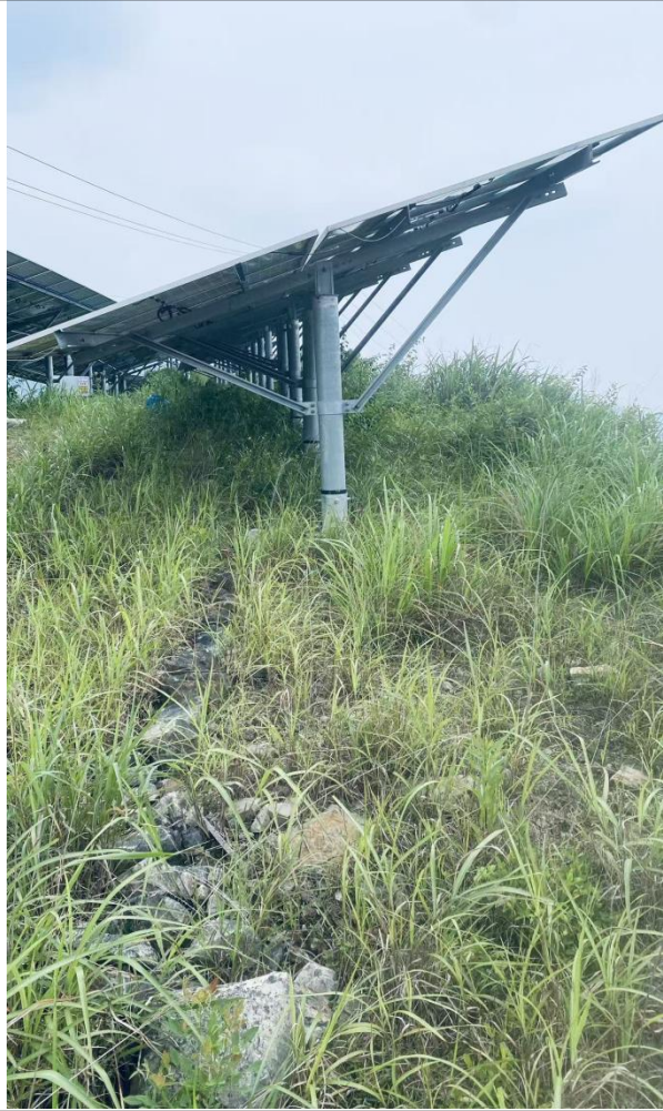
完工后光伏组件场区域照片2025.5
