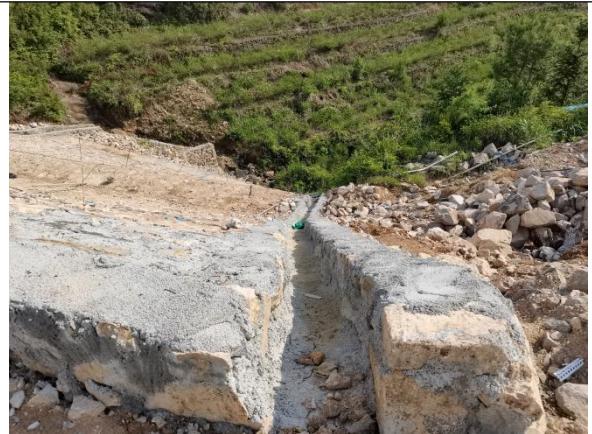
升压站区浆砌石排水沟2022.5
