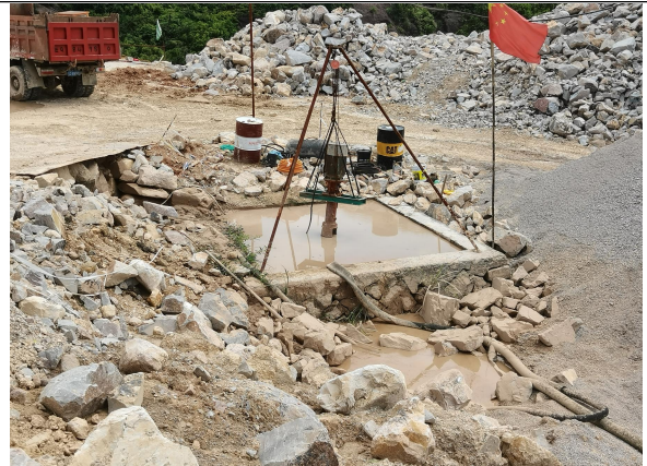
施工期升压站区域沉砂池，2021.6
