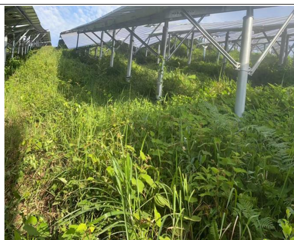
完工后光伏组件场区域照片2025.5
