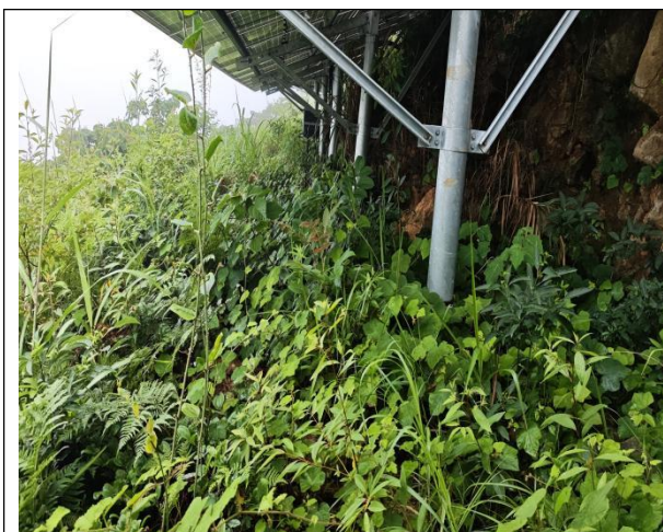
完工后光伏组件场区域照片2025.5
