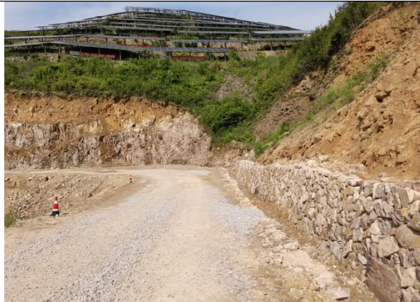
施工期拓宽道路及内侧排水沟，2021.8
