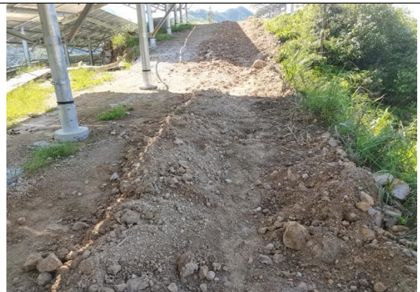
集电线路区域表土回填2022.12
