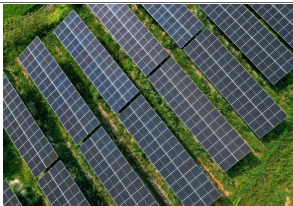
光伏组件及集电线路区域绿化2023.7
