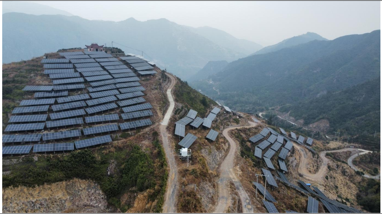
完工后道路及光伏组件场区域照片2023.12
