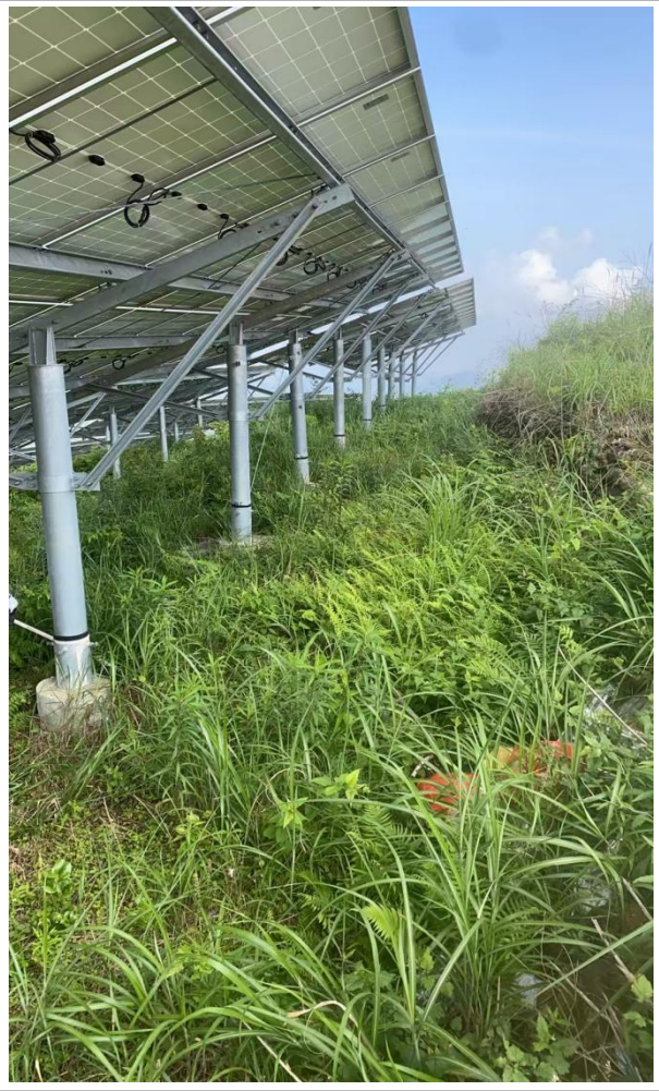
完工后光伏组件场区域照片2025.5
