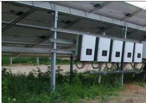
光伏组件及集电线路区域绿化2023.7
