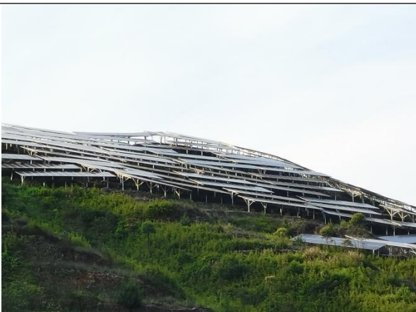
完工后光伏组件场区域情况2023.7
