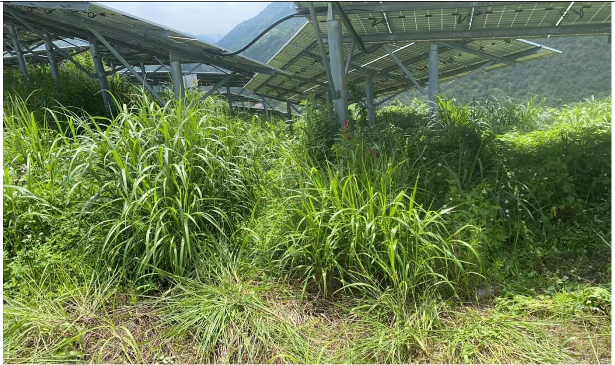
完工后光伏组件场区域照片2025.5
