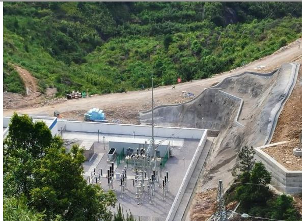
升压站区排水沟2022.1
