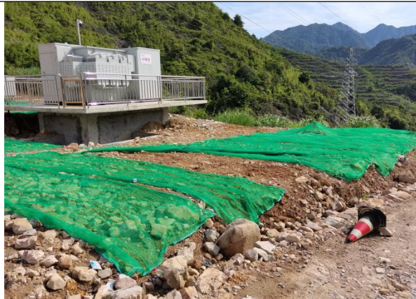
施工期临时苫盖2021.10
