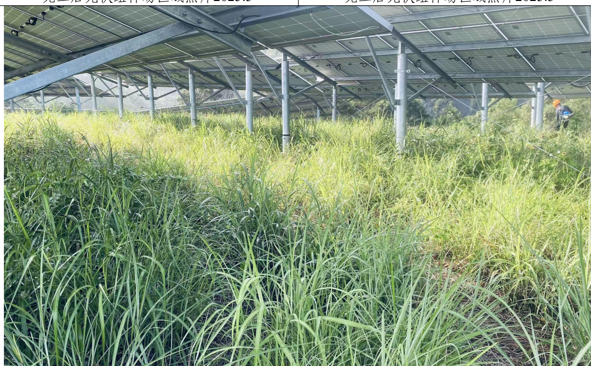
完工后光伏组件场区域照片2025.5
