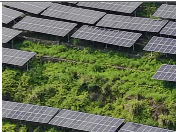
完工后光伏组件场区域情况2023.7
