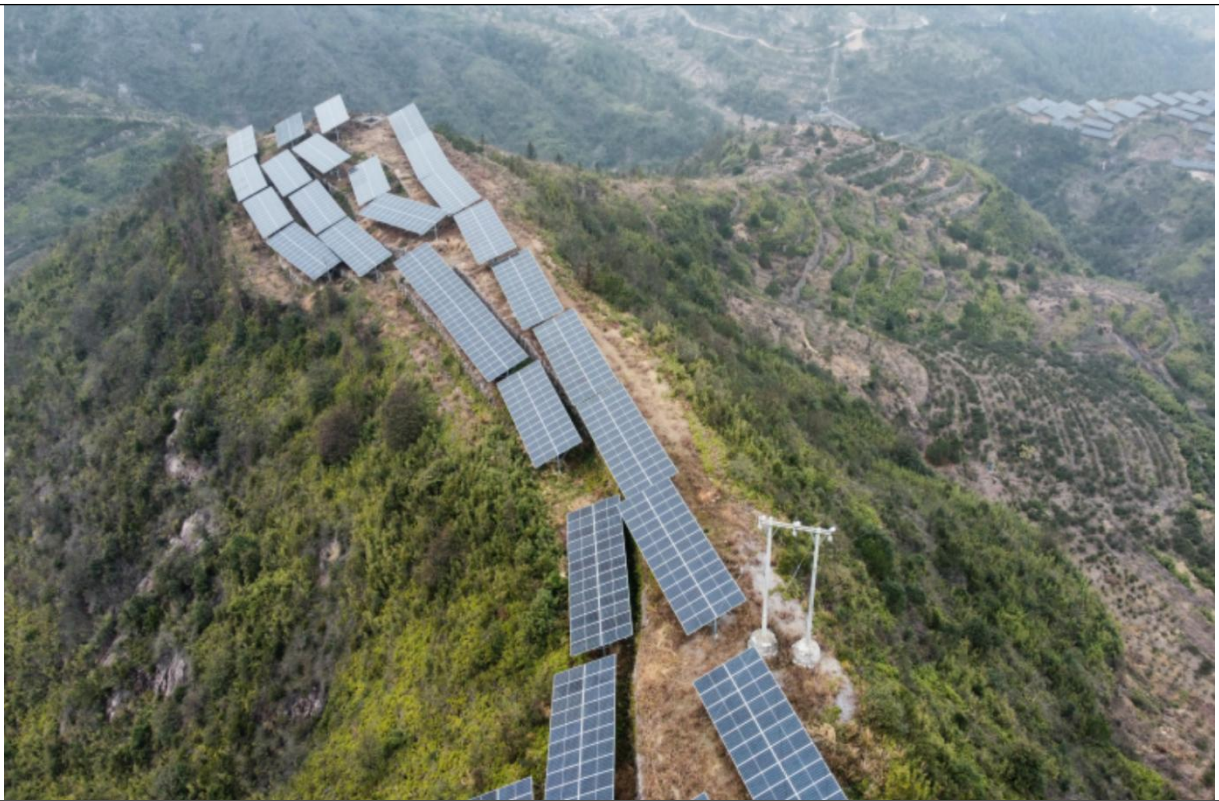
完工后道路及光伏组件场区域照片2023.12
