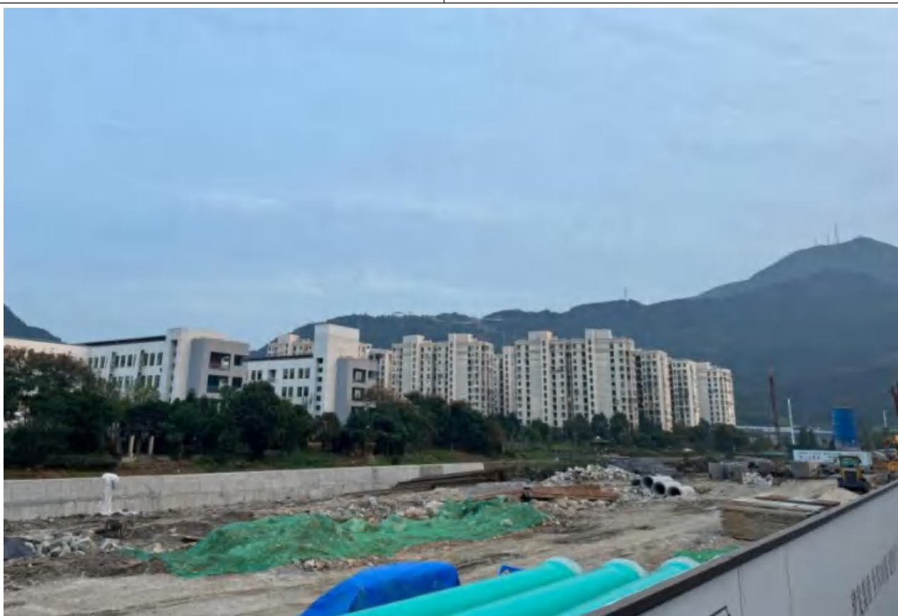
红线外临时占地现状 (东四路, 目前已开工, 处于道路施工阶段)
