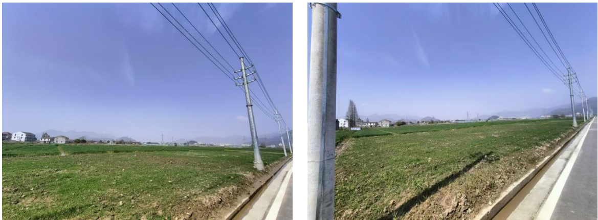
夏桥泵站复垦
