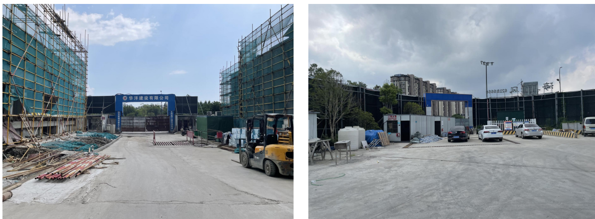
临时苫盖及硬化场地
