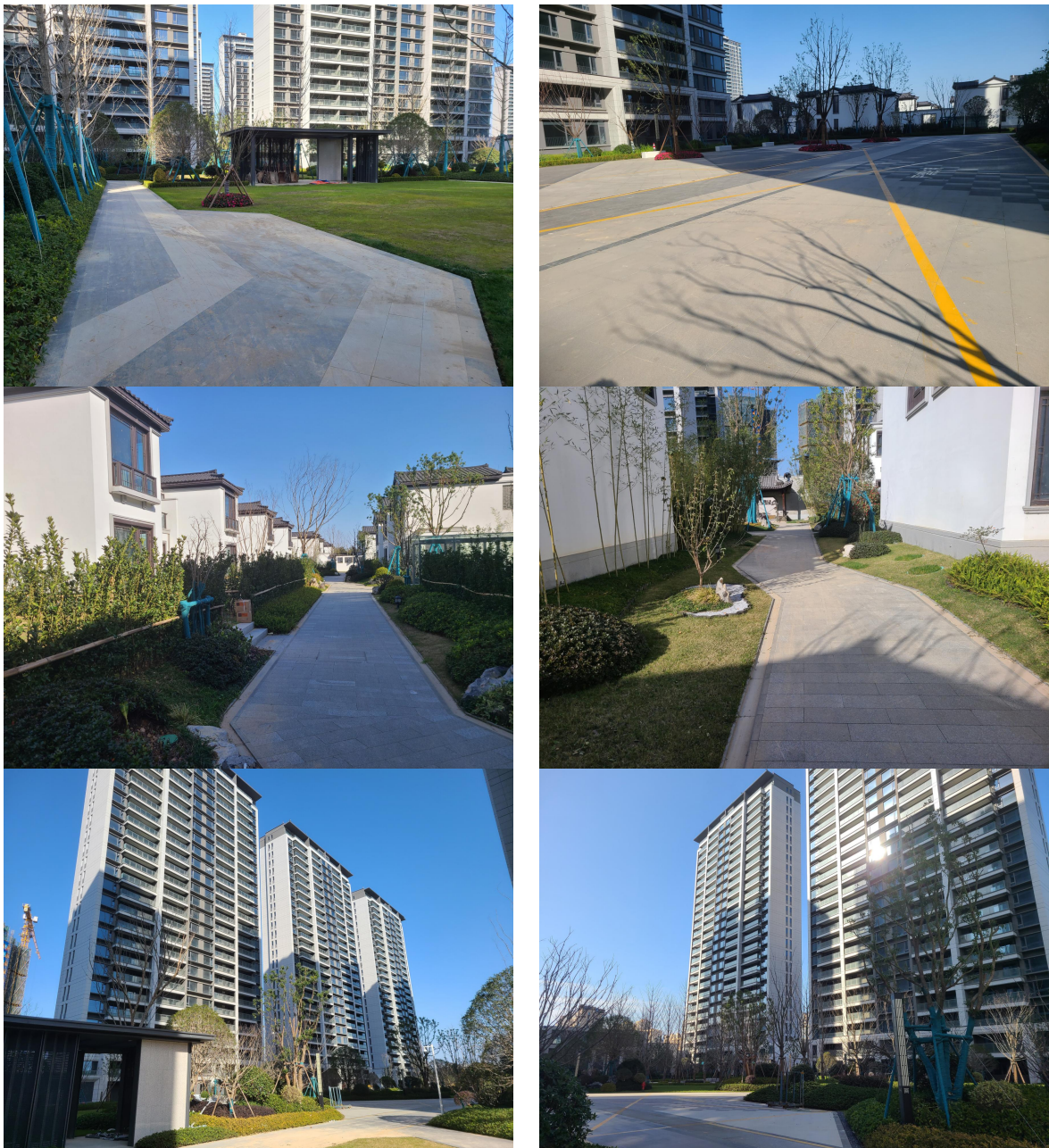
项目区及水土保持设施现场核查照片
