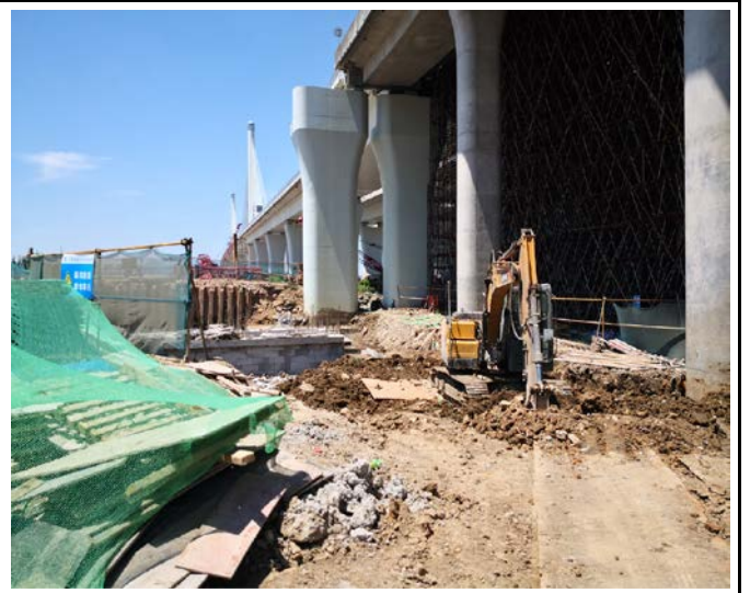
北岸桥头堡施工
