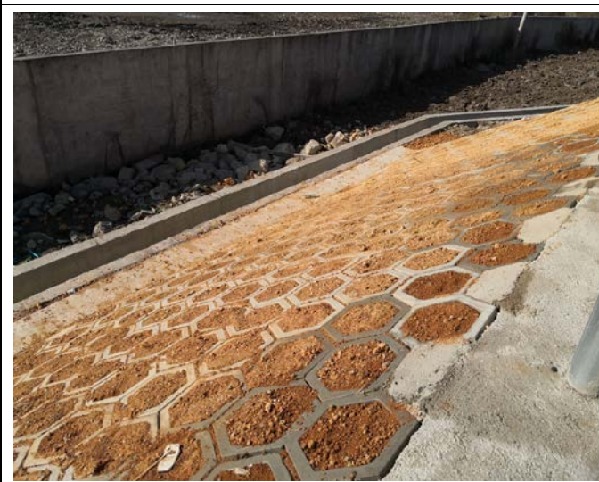
匝道路基边坡框格植草、路基排水边沟
