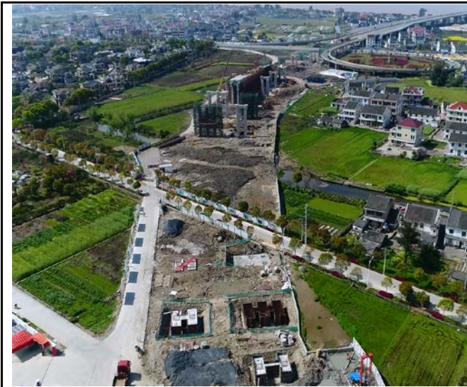
七都侧主体工程施
