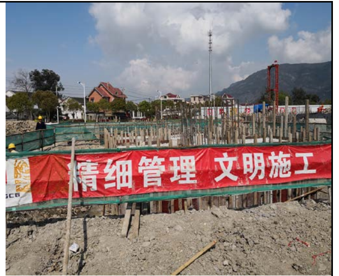
主线陆地引桥承台施工
