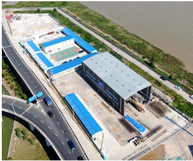
永嘉侧施工临时设施
