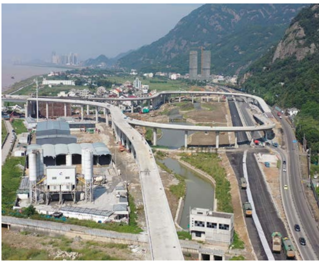
永嘉侧陆上施工
