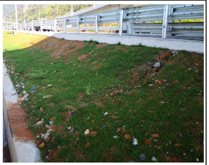
路基边坡喷播植草绿化
