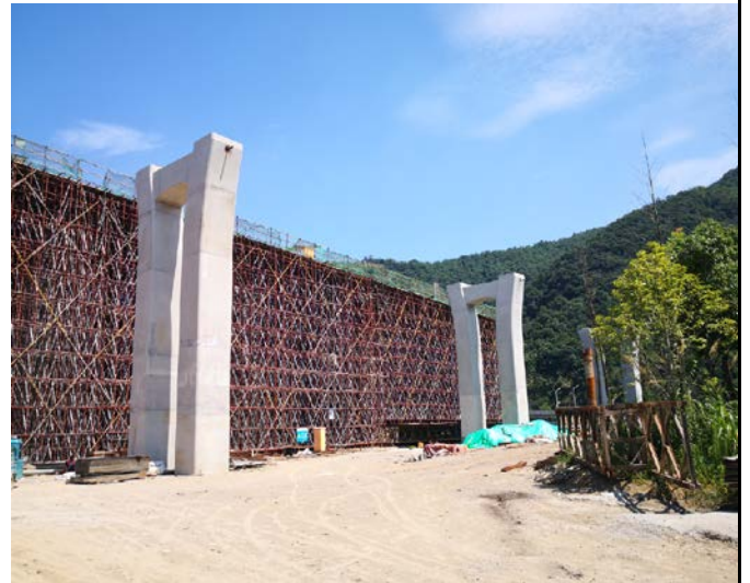
北岸引桥现浇箱梁满堂施工
