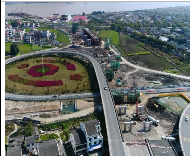
七都侧施工扰动面
