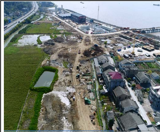
瓯北侧陆上施工
