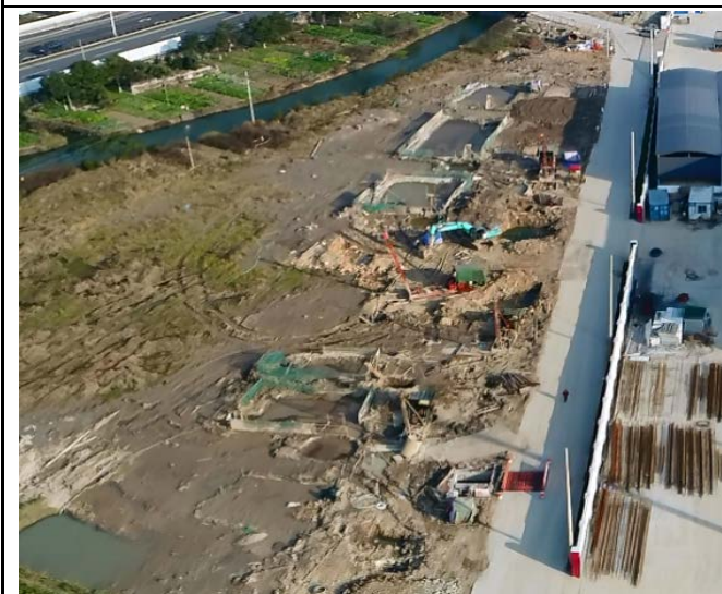
陆上桩基施工
