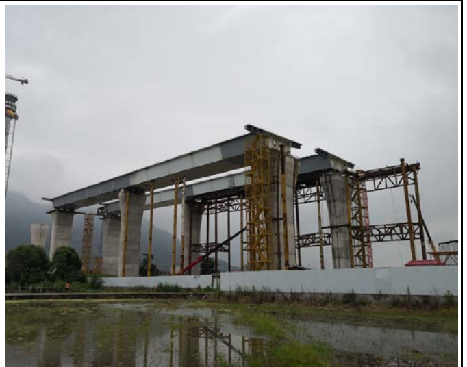
陆地引桥箱梁施工
