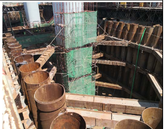
水中拼宽桥承台施工
