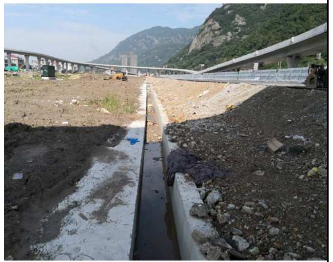
104国道改建工程路基边坡、排水沟
