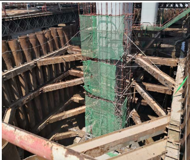
水中拼宽桥承台施工
