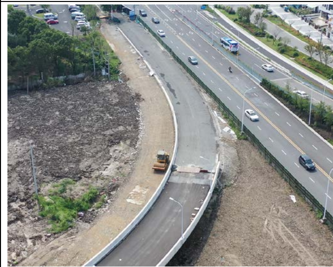
C 匝道路基填筑及防护
