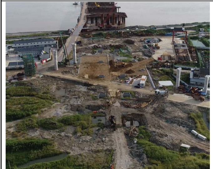
陆地引桥桩基、承台施工
