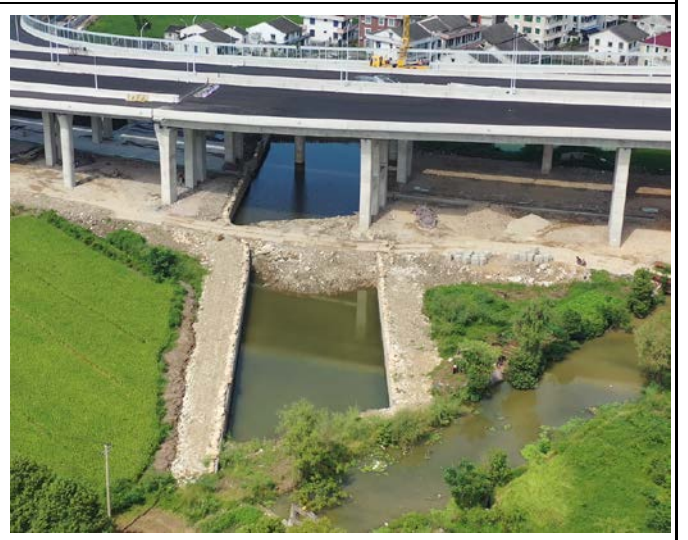
河道改移工程挡墙施工
