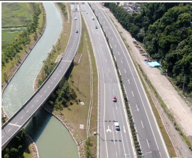
104 国道路基边坡绿化及排水边沟
