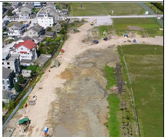
匝道桩基施工
