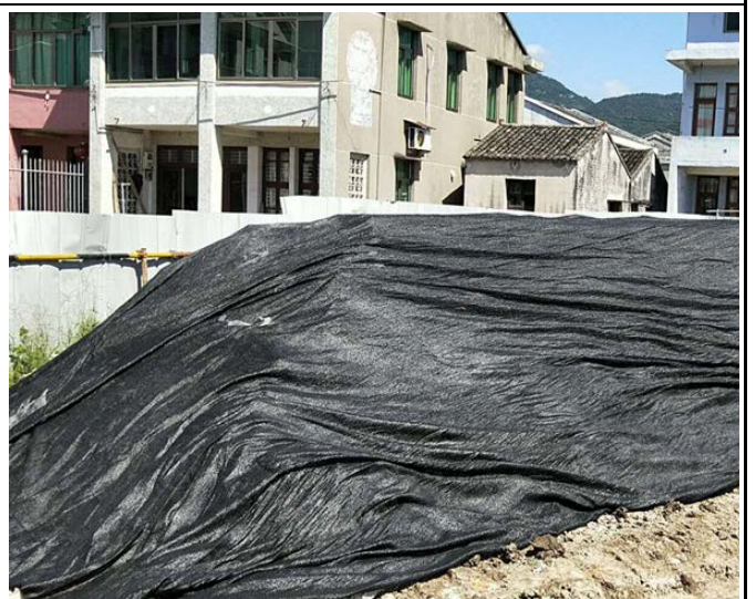
临时遮盖措施
