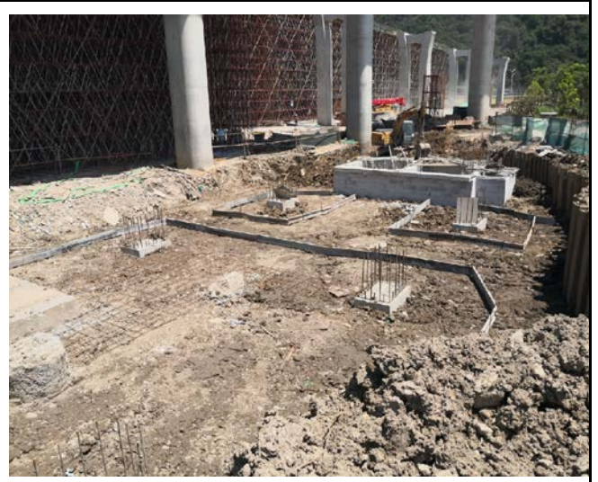
人行楼梯及电梯基础施工
