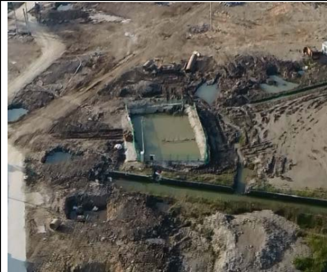
桩基施工泥浆池
