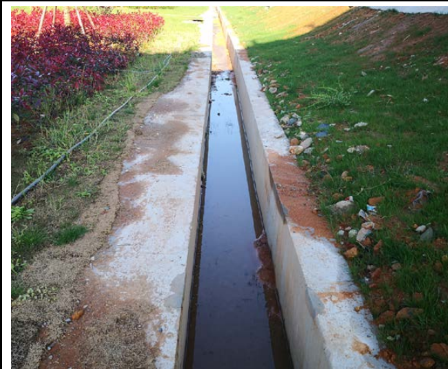
104 国道改建段路基排水沟
