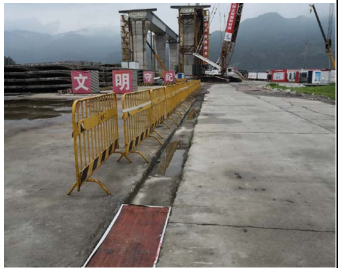
施工场地（施工便道）临时排水沟
