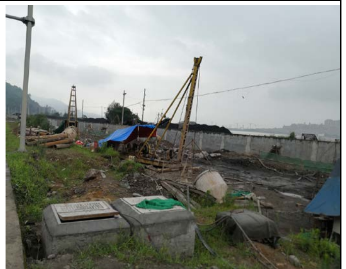
SE 隧道桩基施工
