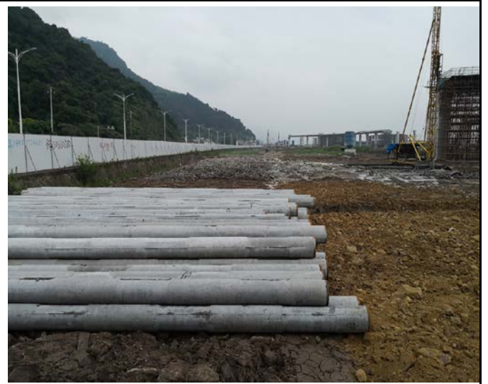
104 国道改建段水泥搅拌桩（管桩）
