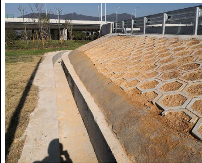
路基边坡框格植草、路基排水边沟
