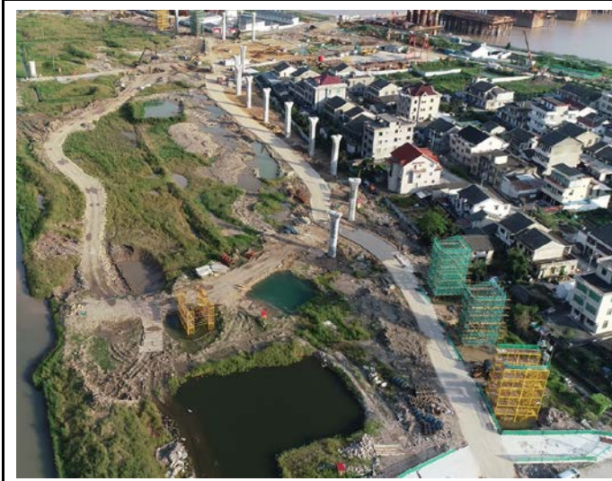
匝道桥桩基、承台、立柱施工
