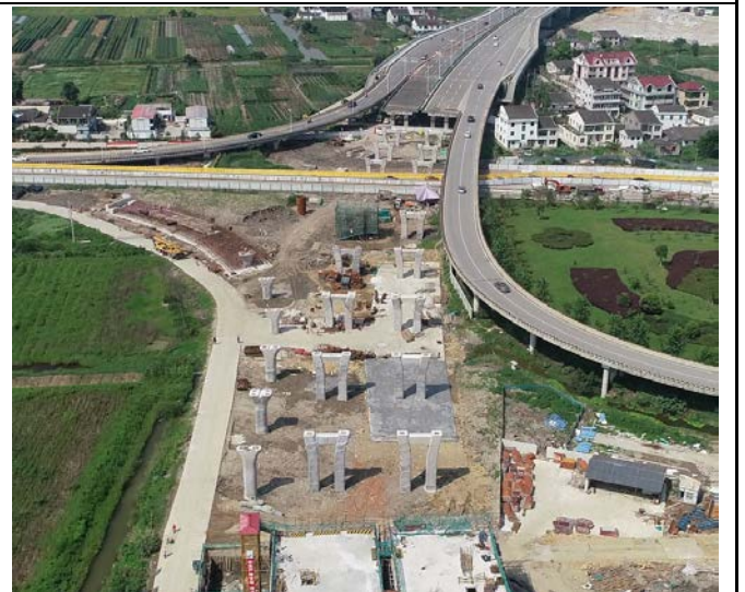
起点处引桥立柱施工
