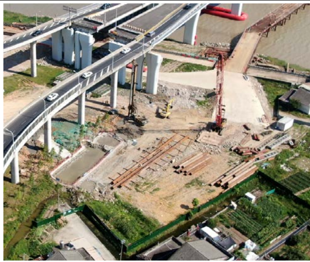
匝道变更桩基施工
