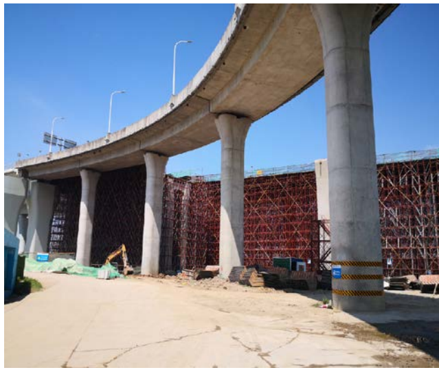
北岸引桥现浇箱梁施工
