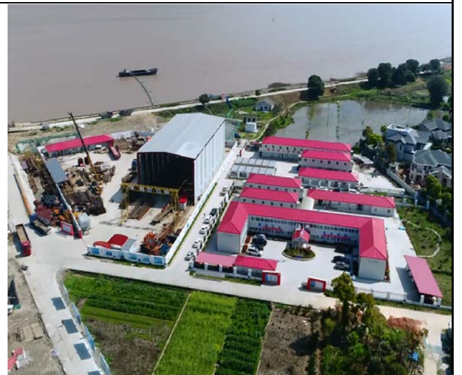
施工临建（施工用房、钢筋加工棚等）
