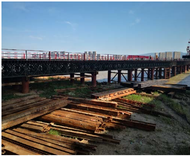
水中临时栈桥
