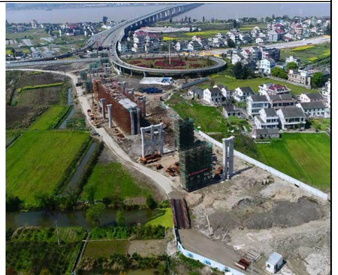
主线靠近起点处立柱施工
