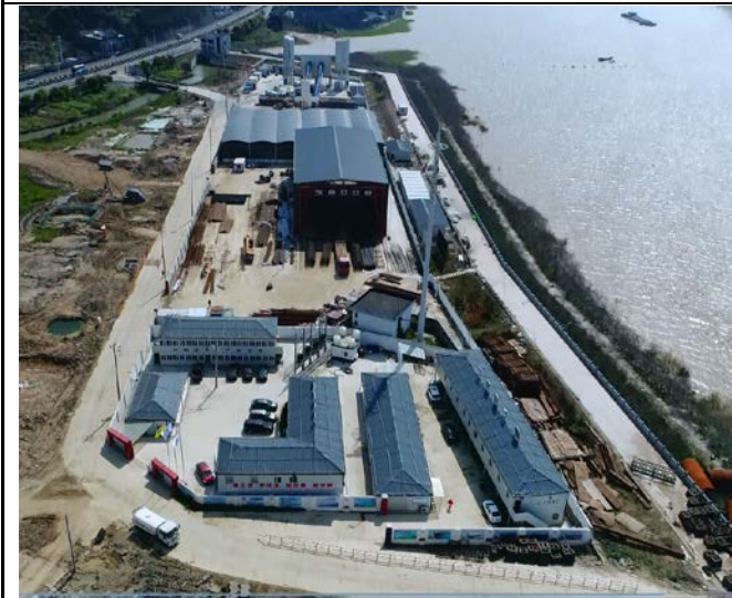
永嘉侧施工临建
