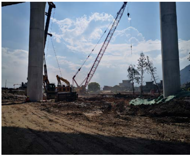
桩基施工场地
