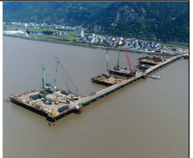
水上平台及桩基施工
