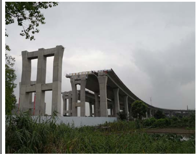
主线引桥、D匝道桥箱梁架设
