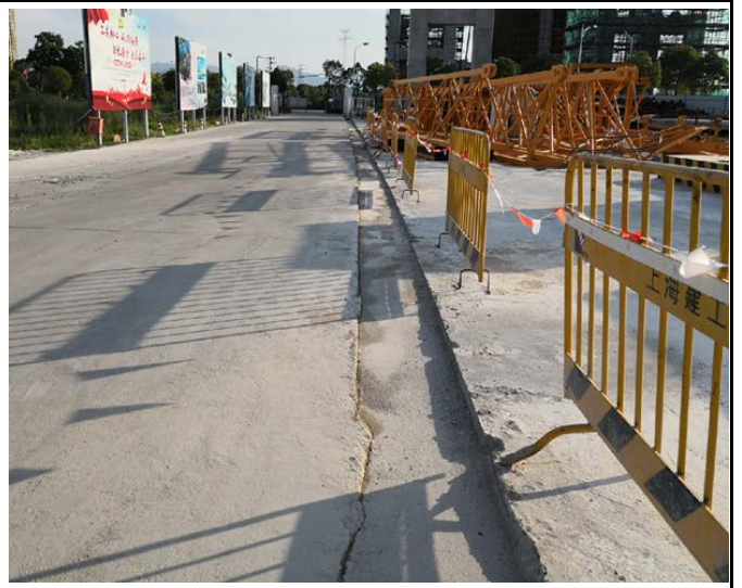
施工场地临时排水沟
