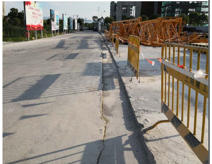
施工场地临时排水沟
