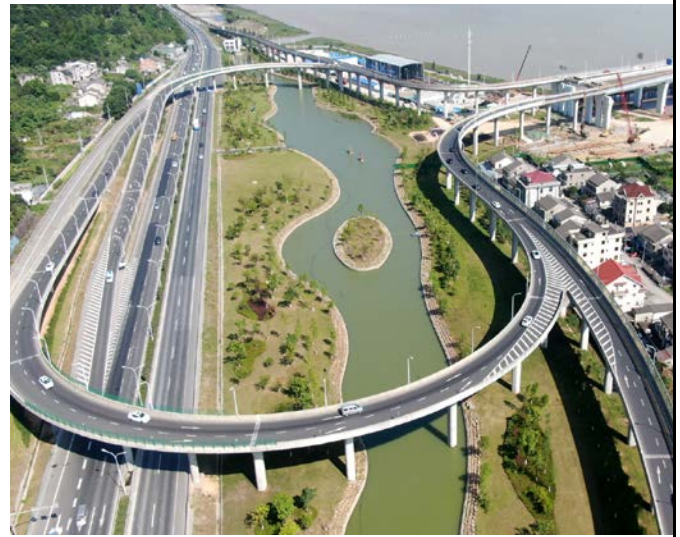
永嘉侧匝道及绿化现状
