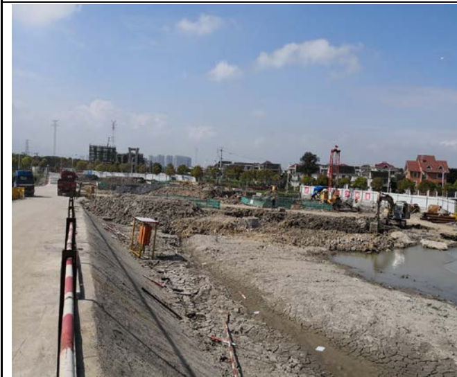
主线路堤引桥施工
