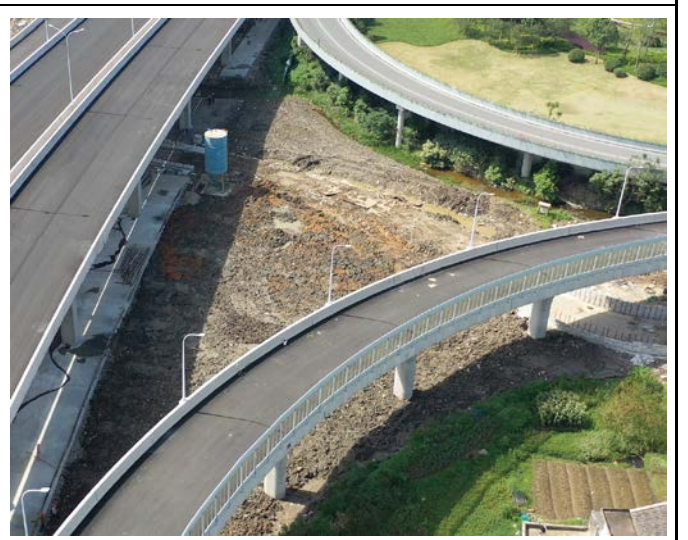
施工场地平整
