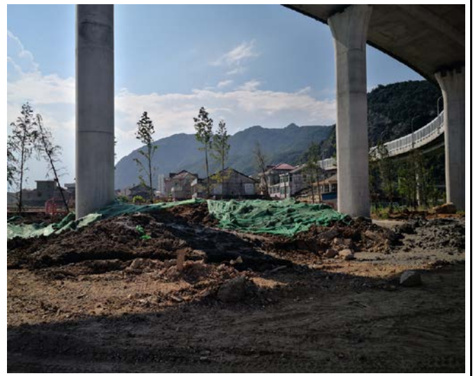
施工场地裸露区域临时苫盖
