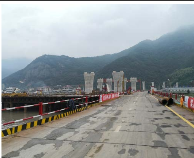
引桥立柱施工
