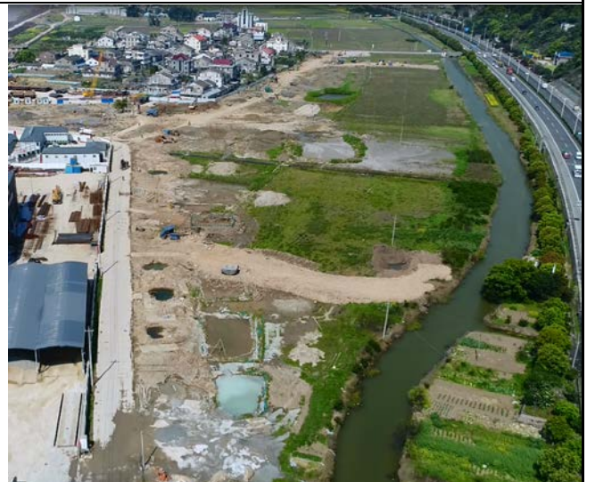
陆上枢纽处匝道施工
