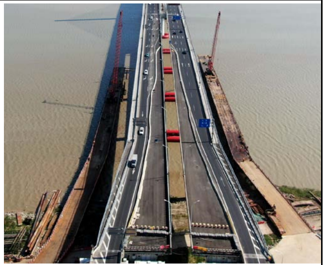
两侧水上栈桥施工
