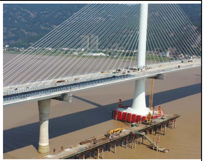
水上主桥（鹿城侧）
